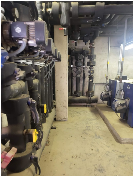
Coletores y Bombas a Modificar
