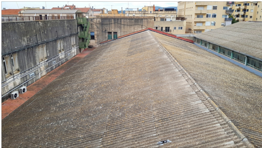
Vessant Sud coberta
