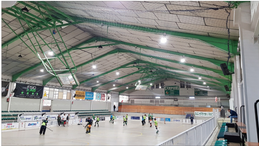
LATERAL EST DE LA PISTA PRINCIPAL
