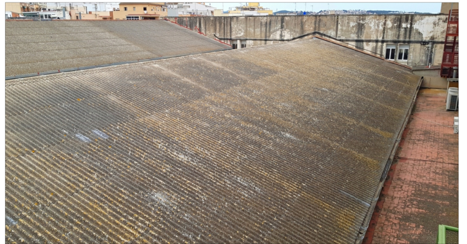
Vessant Sud coberta - vista a Nord-Oest
