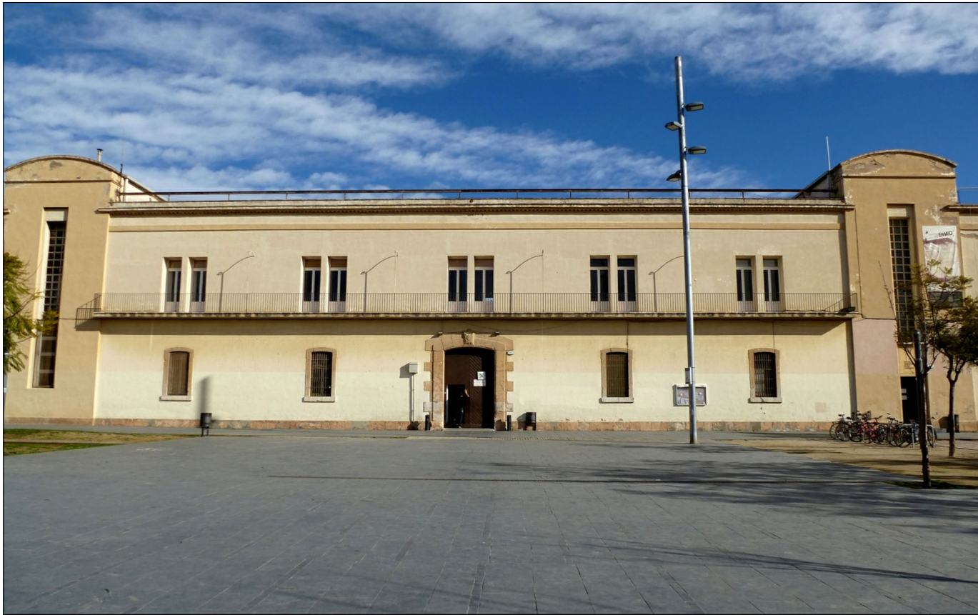
FAÇANA PLAÇA DE LES CASERNES
