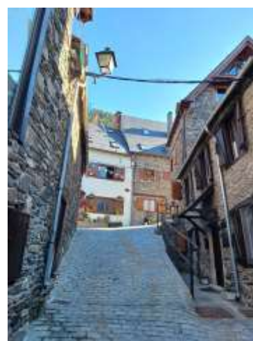
Pavimento de lambordí de granito
