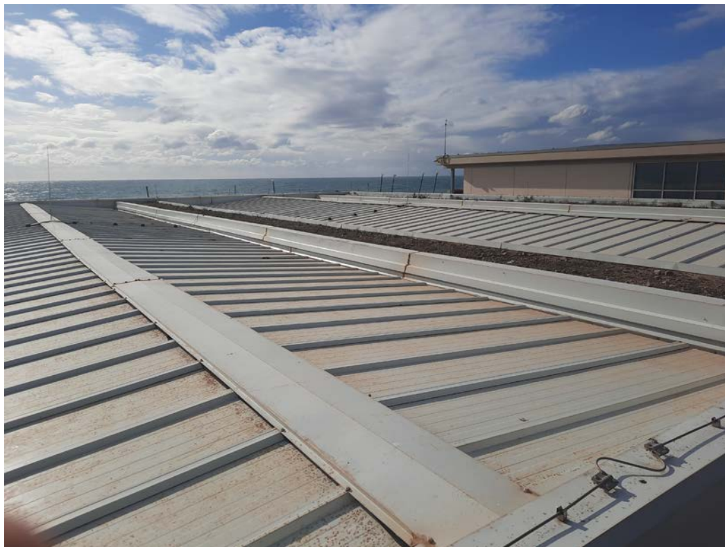
Vista coberta amb jardinera
