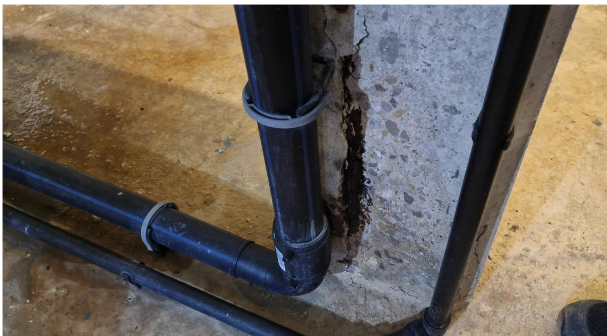
Figura 13. Arrencada de pilars centrals on s'aprecia una pèrdua de recobriment molt significativa amb armadura vista corrosionada. S'aprecien esquerdes addicionals en altres punts que indiquen que l'expansió de l'acer per corrosió va avançant. S'aprecia aigua salina en terra. Fotografia de 06/02/2023
