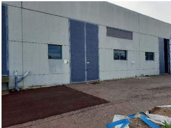
façana oest exterior
