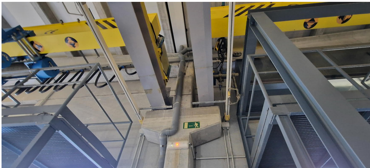
Figura 9. Els pilars tenen unes mènules on recolzen uns ponts grua. L'estat de conservació dels pilars i mènules sembla adequat. Fotografia de 06/02/2023
