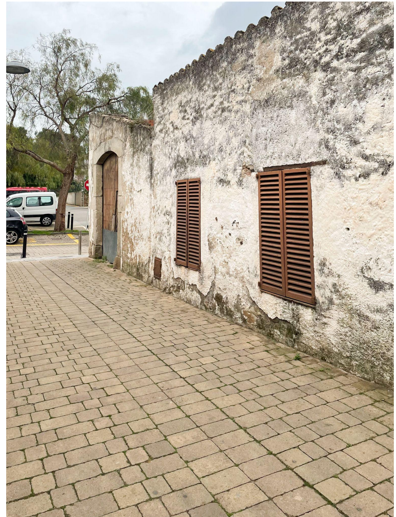
▲ Foto 4: Passatge d'En Pere Sardó, construccions que seran retirades
