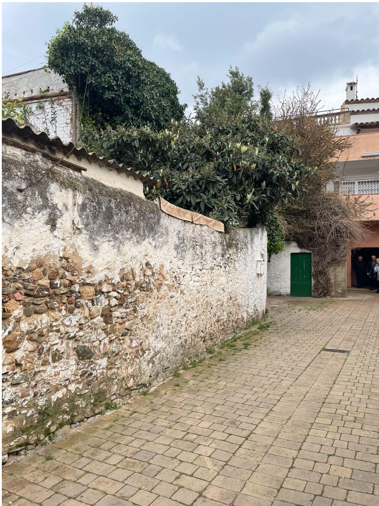
▲ Foto 5: Passatge d'En Pere Sardó, construccions que seran retirades
