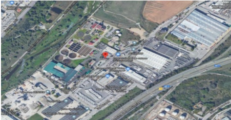
Figura 1. Vista aèria del Centre Comarcal de Tractament de Residus del Vallès Oriental. Les coordenades són: latitud (41°34'1.55"N) i longitud (2°16'20.30"E).
