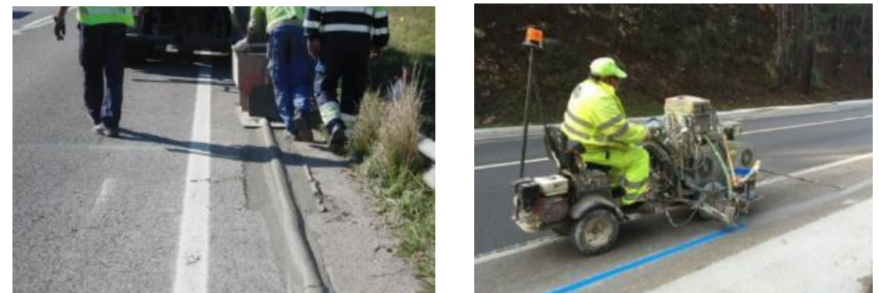
Procés de rebliment de la rasa amb morter i exemple dels treballs de pintat de la línia blava
