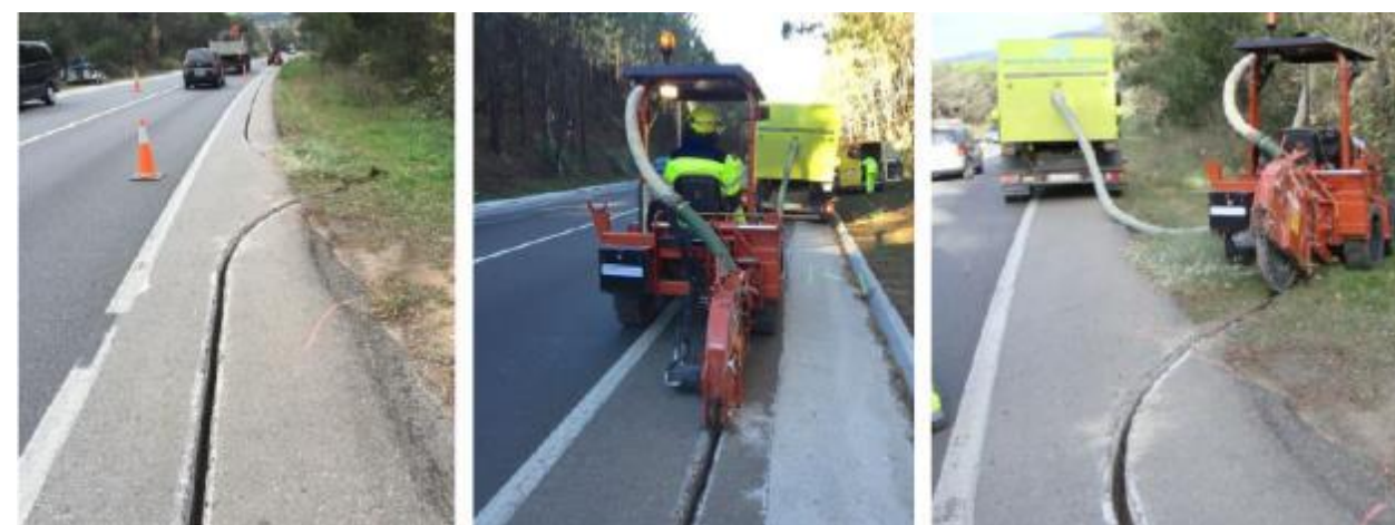
Exemple de microrasa, treballs d'obertura de microrasa i gir de sortida de calçada per col·locació d'un pericó
