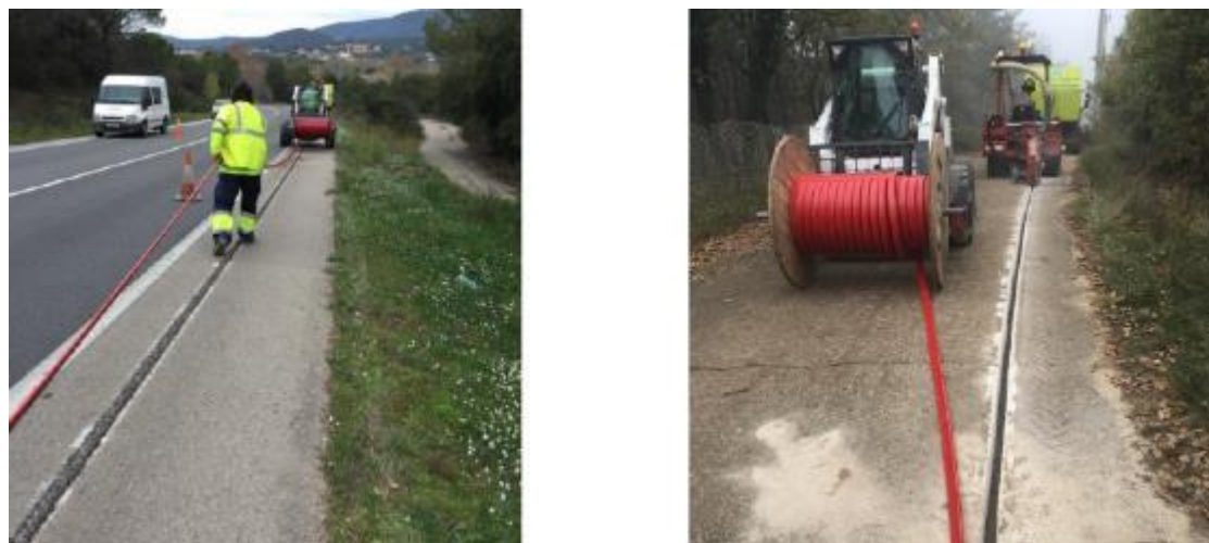
Exemple de treballs d'estesa manual de microductes i exemple d'obertura i estesa simultànies
