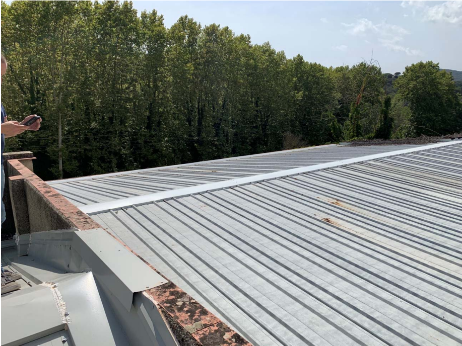
Foto 05_ Coberta a substituir
