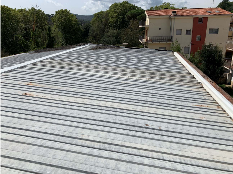
Foto 06_ Coberta a substituir
