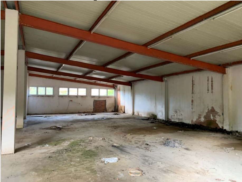
Foto 04_ Estructura coberta a substituir
