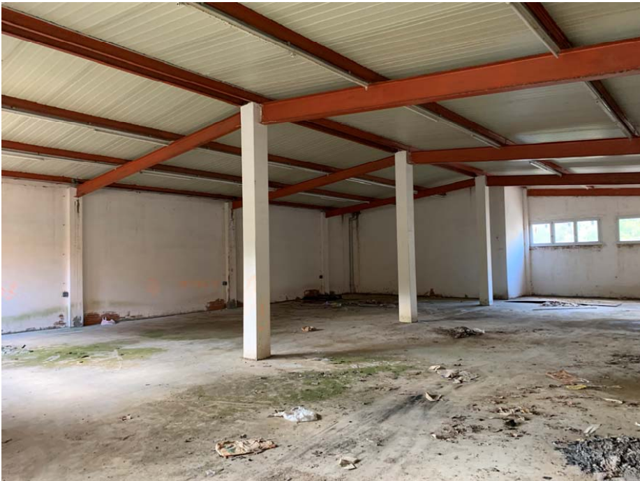
Foto 03_ Estructura coberta a substituir
