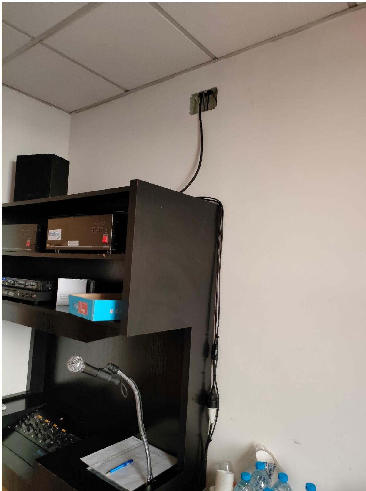
Caixa de derivació a tapar
