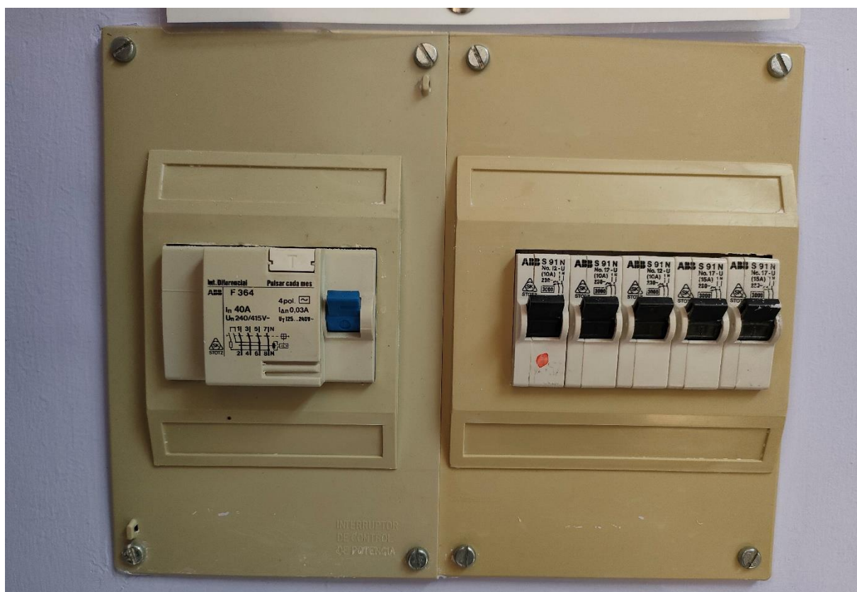
Consultori Mèdic Instal·lar nou quadre superficial amb tancament amb clau
