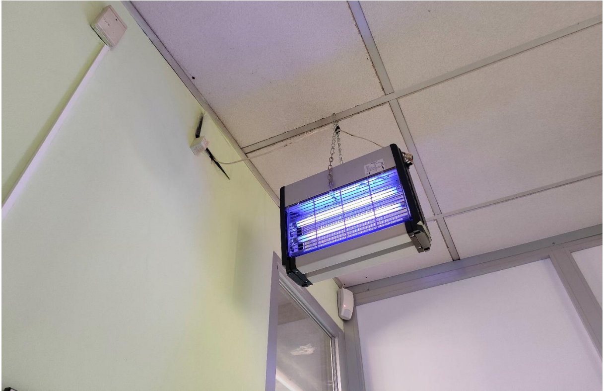
Llar d'infants: Instal·lar toma de corrent al sostre i retirar la regleta de connexió
