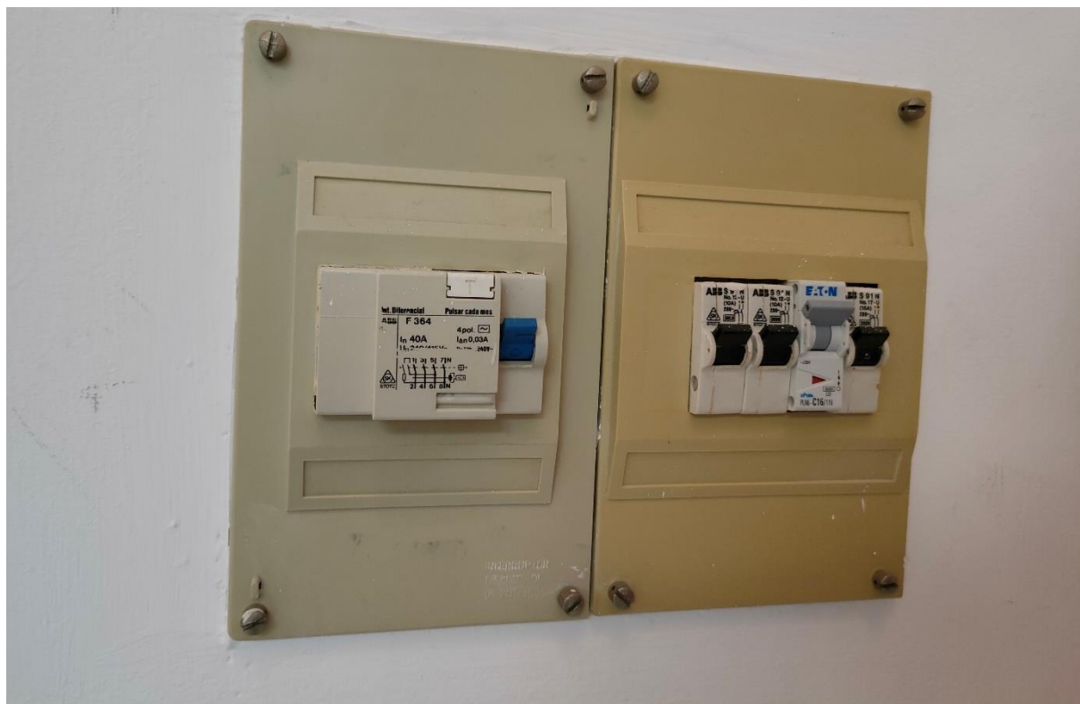
Sala d'exposicions Instal·lar nou quadre superficial amb tancament amb clau
