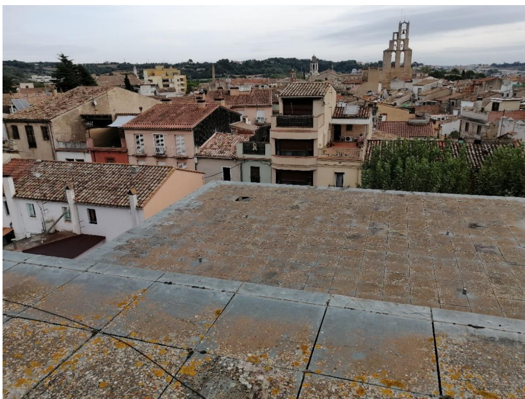
Figura 7. Imatges de les cobertes objecte de projecte. Coberta oest a dalt i coberta est a baix Font: Elaboració pròpia.
