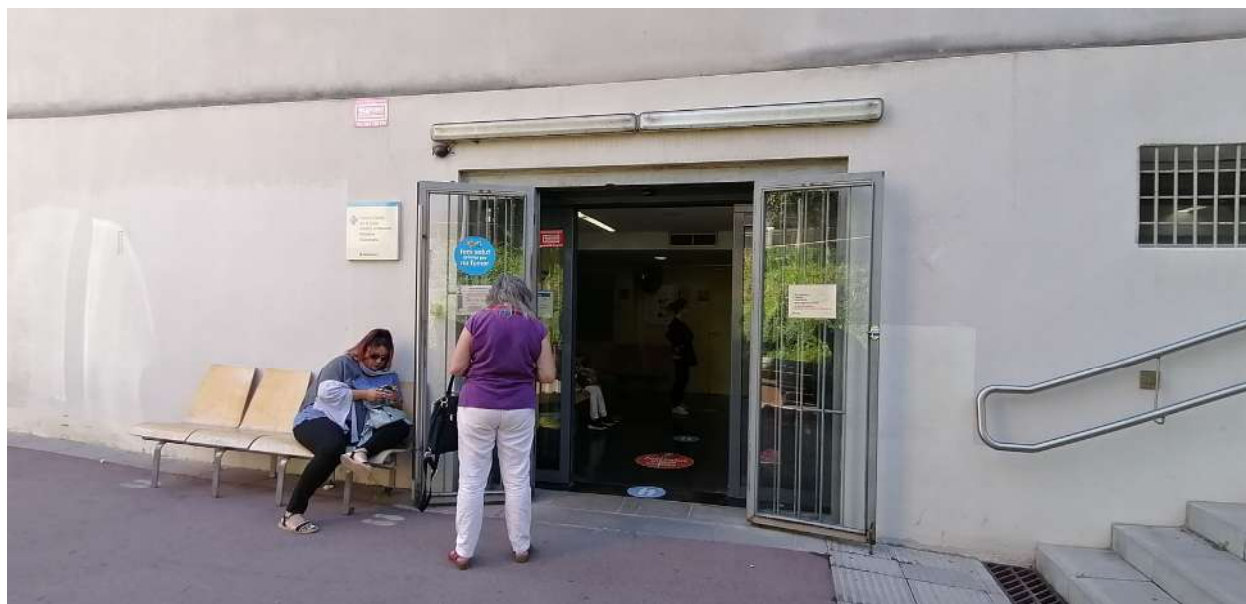
Entrada des de l'espai públic a la planta semisoterrani del CAP
