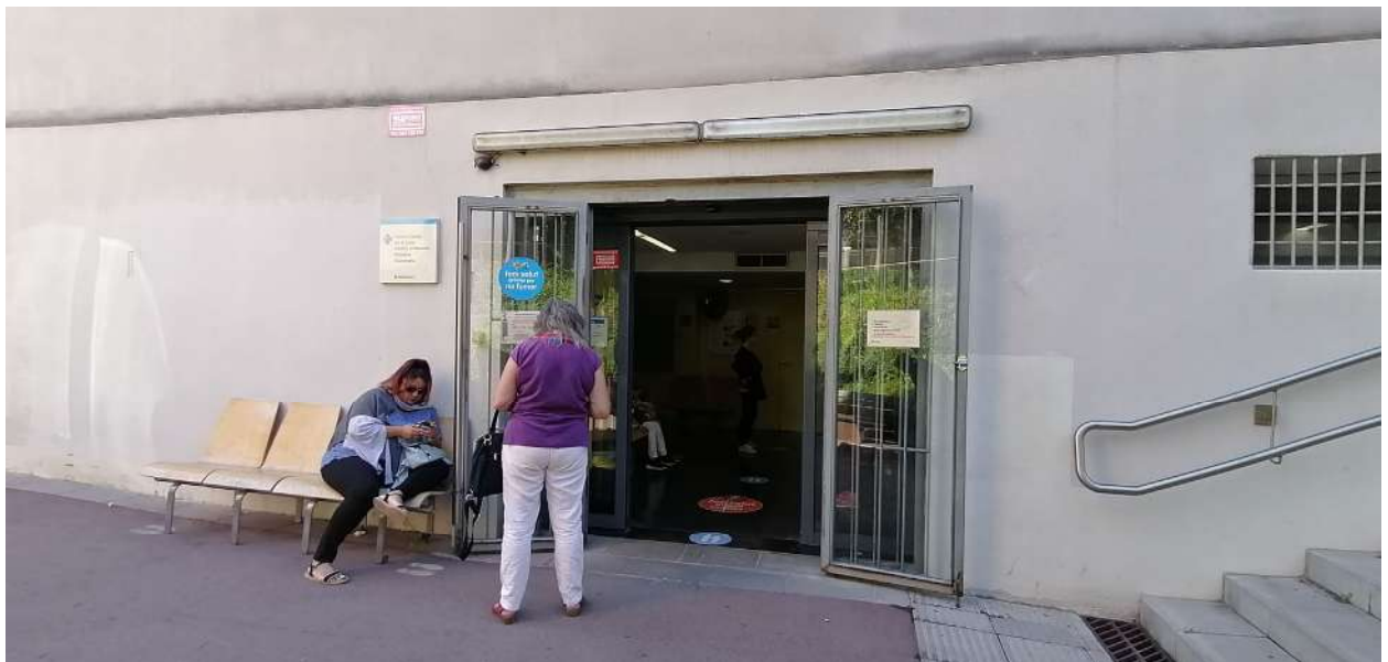
Entrada des de l'espai públic a la planta semisoterrani del CAP
