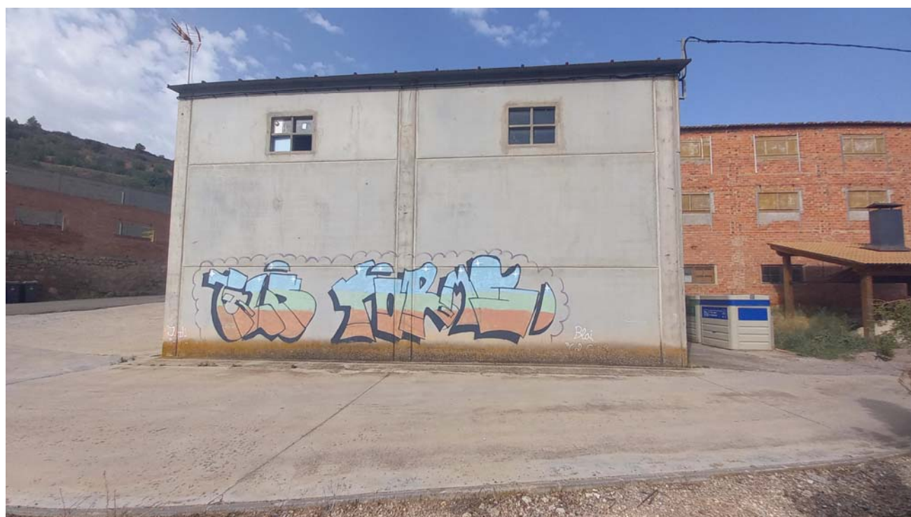
Façana lateral (EST)
