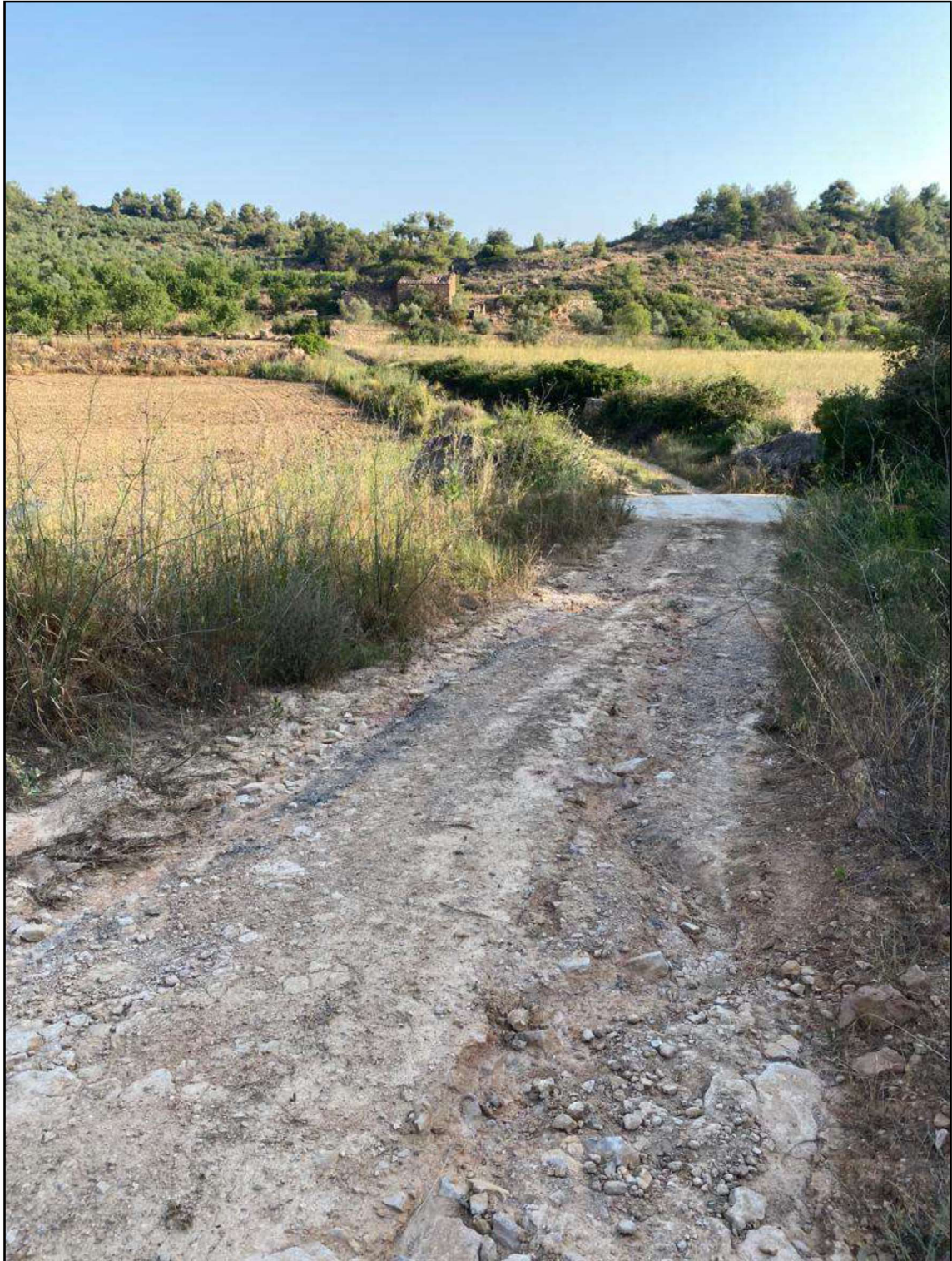
Foto 3. Tram inicial del Camí de les Mitjanes (PK 0+620), amb una amplada de 3,30 metres, amb molta vegetació a les vores i amb un ferm irregular i pedregós.
