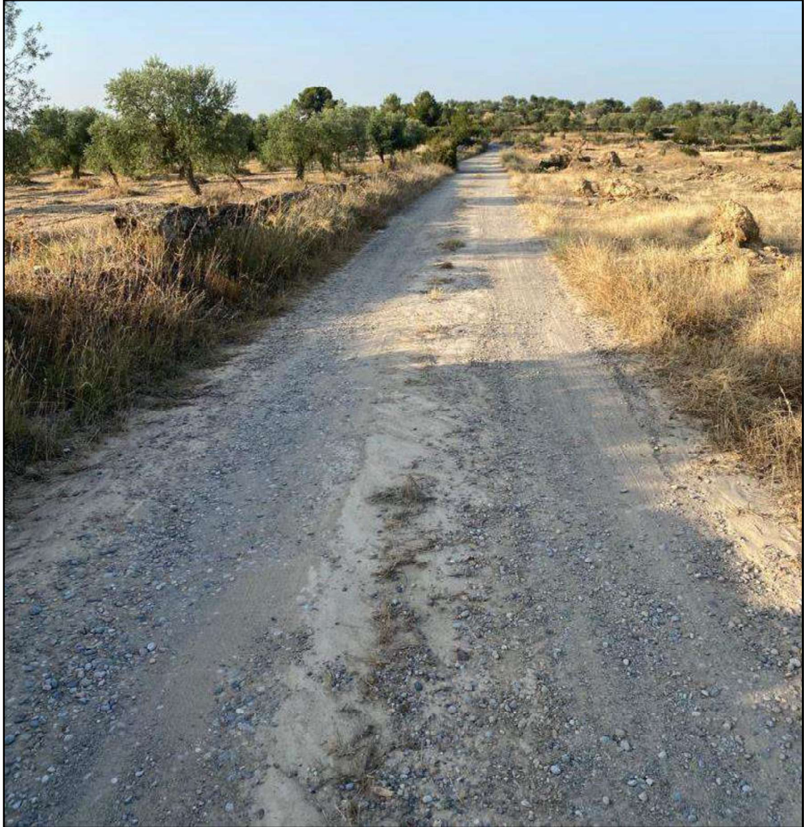
Foto 1. Tram inicial del Camí de les Llacunes, (PK 0+260), amb una amplada de 3,5 metres, i amb finques d'olivers i ametllers a les vores.
