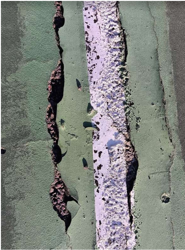
Foto 8: Aixecament de l'última capa de paviment continu.
