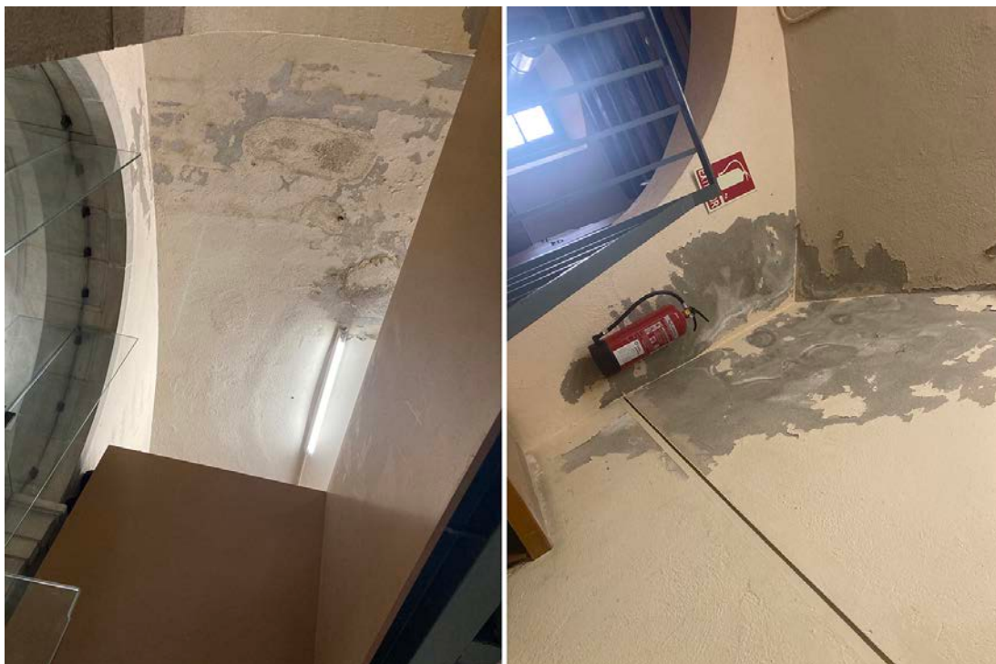
Fotografies interiors de la zona del magatzem: voltes amb descrostats
