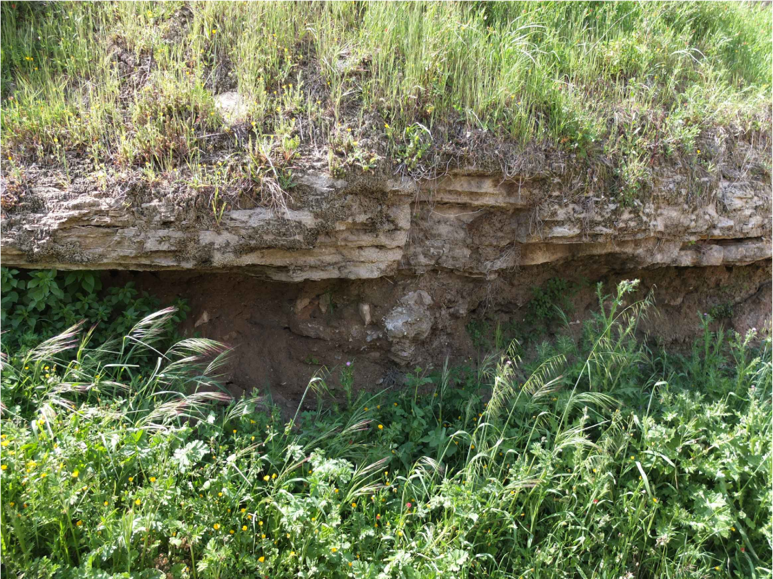
V2. Soscavacions, descalçaments i formació de balmes sota l'estrat rocós de pedra de guix i guix granular. Degradació del basament. Descompressió i inestabilitat. Font: GAA 19/04/2018
