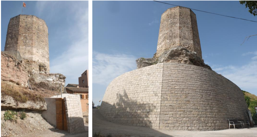
Imatges del mur de contenció realitzat l'any 2021, a continuació de l'executat l'any 2003. Font: GAA
