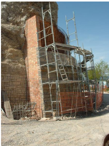
Actuacions per a la reparació del basament de la torre d'Òdena. Octubre 2002 - juliol 2003.
