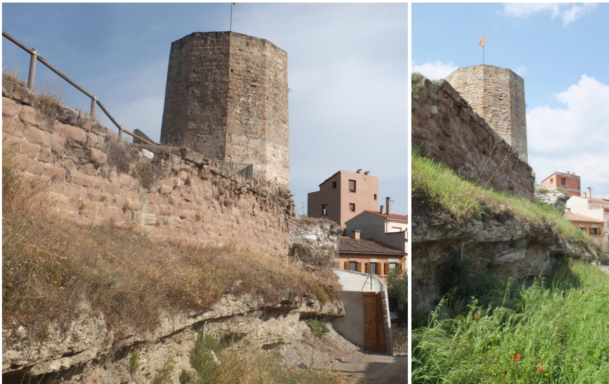
Imatges dels estrats rocosos del basament oriental de la torre d'Òdena. Font: GAA 16/06/2021 - 19/04/2018
