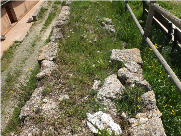
V9. Vista del coronament de la muralla medieval. Font: GAA 19/04/2018
