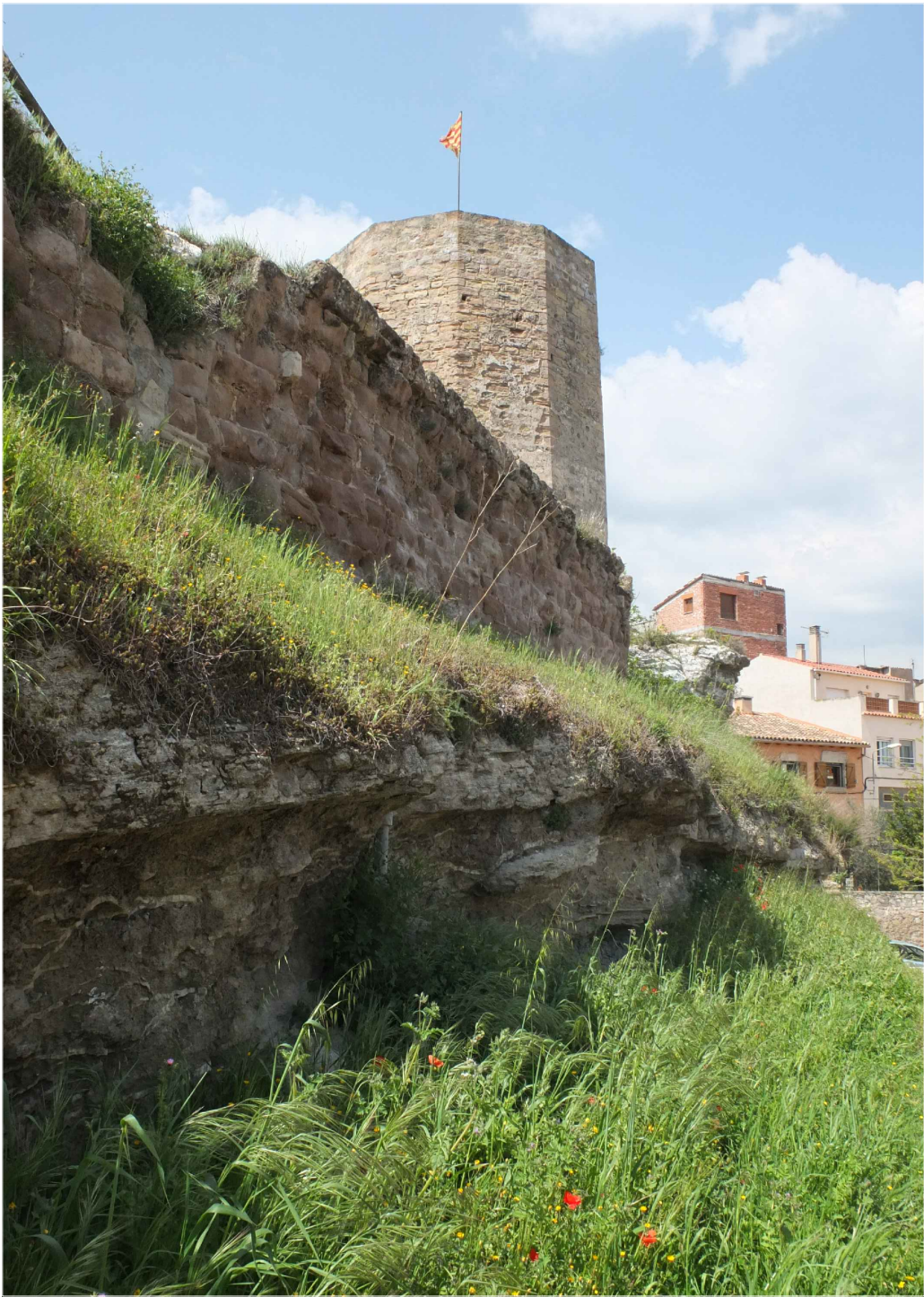
V13. Vista de les balmes i de la descompresabilitat del basament de la torre d'Òdena i muralla medieval. Estrat de roques de guix i al fons, la torre de l'homenantge. Font: GAA 19/04/2018
