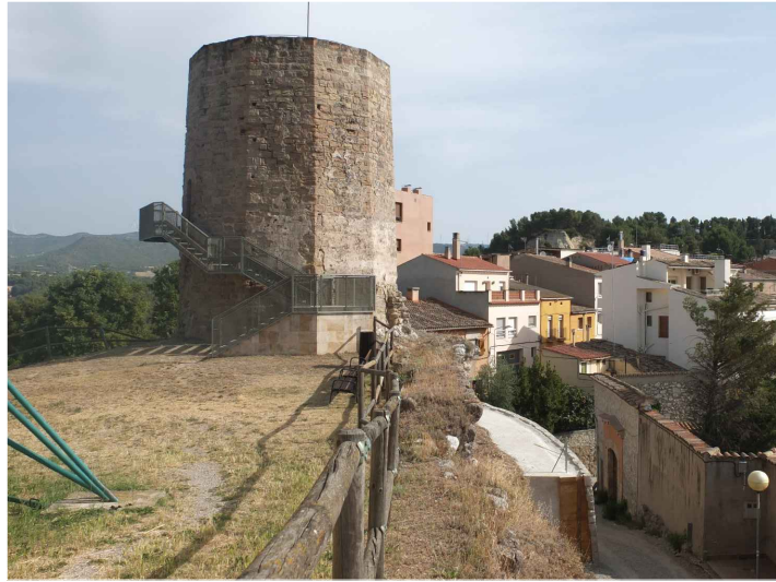
V7. Vista de la torre des de migdia. Font: GAA 16/06/2021
