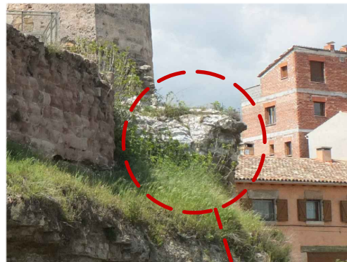
Estrat rocós en voladís. Soscavació i descalçament.
