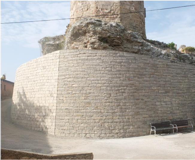
V2. Vista de la torre des de la cruïlla del carrer La torre i el carrer de la Guixera. Font: GAA 16/06/2021
