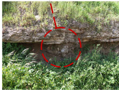
Soscavacions i descalçaments. Balmes.
