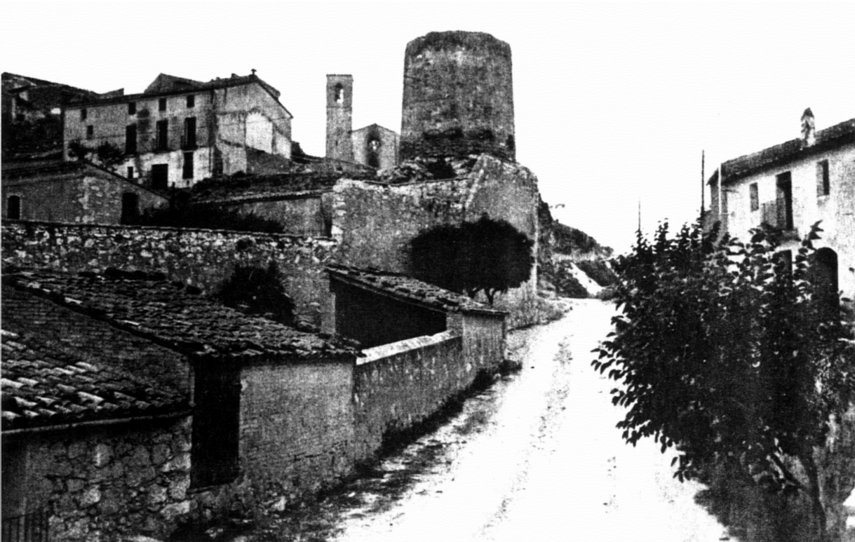
V4. Vista de l'entorn més immediat de la torre de l'homenatge d'Òdena. Font: Arxiu municipal
