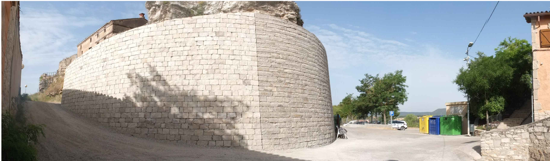
V1. De esquerra a dreta: vista de l'àmbit d'intervenció del sector nord-est del basament de la torre d'Òdena. Vista del mur preexistent construït l'any 2003 i el Tram 1 construït l'any 2021. Font: GAA 16/06/2021
