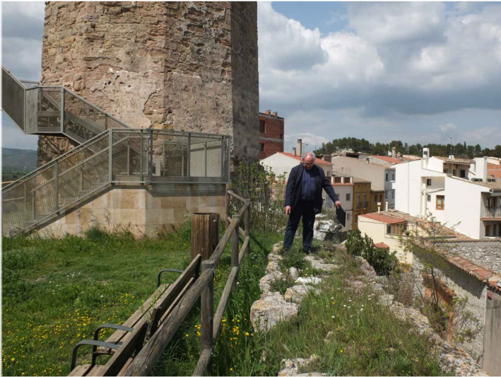
V8. Vista de la torre, l'escala d'accés i la muralla medieval. Font: GAA 19/04/2018
