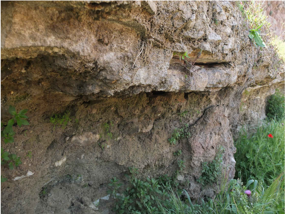
V1. Descompressibilitat, suscavació i descalçament del basament dels estrats rocosos de la torre. Presència de guix granular en els alguns dels estrats rocosos. Font: GAA 19/04/2018
