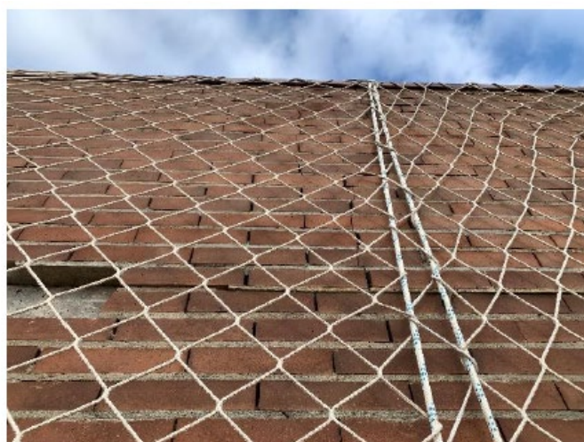
Fig. 3. Estat actual façana.
