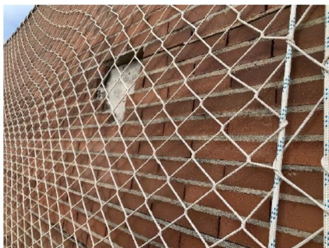
Fig. 4. Estat actual façana.
