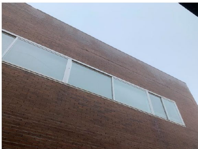
Fig. 1. Estat actual façana.
