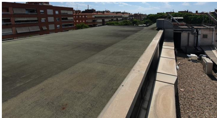
Foto 12 Coberta lliure per instal·lar plaques fotovoltaïques
