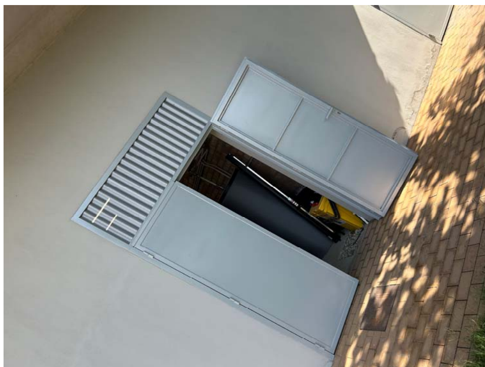
Entrada nova sala de filtres
