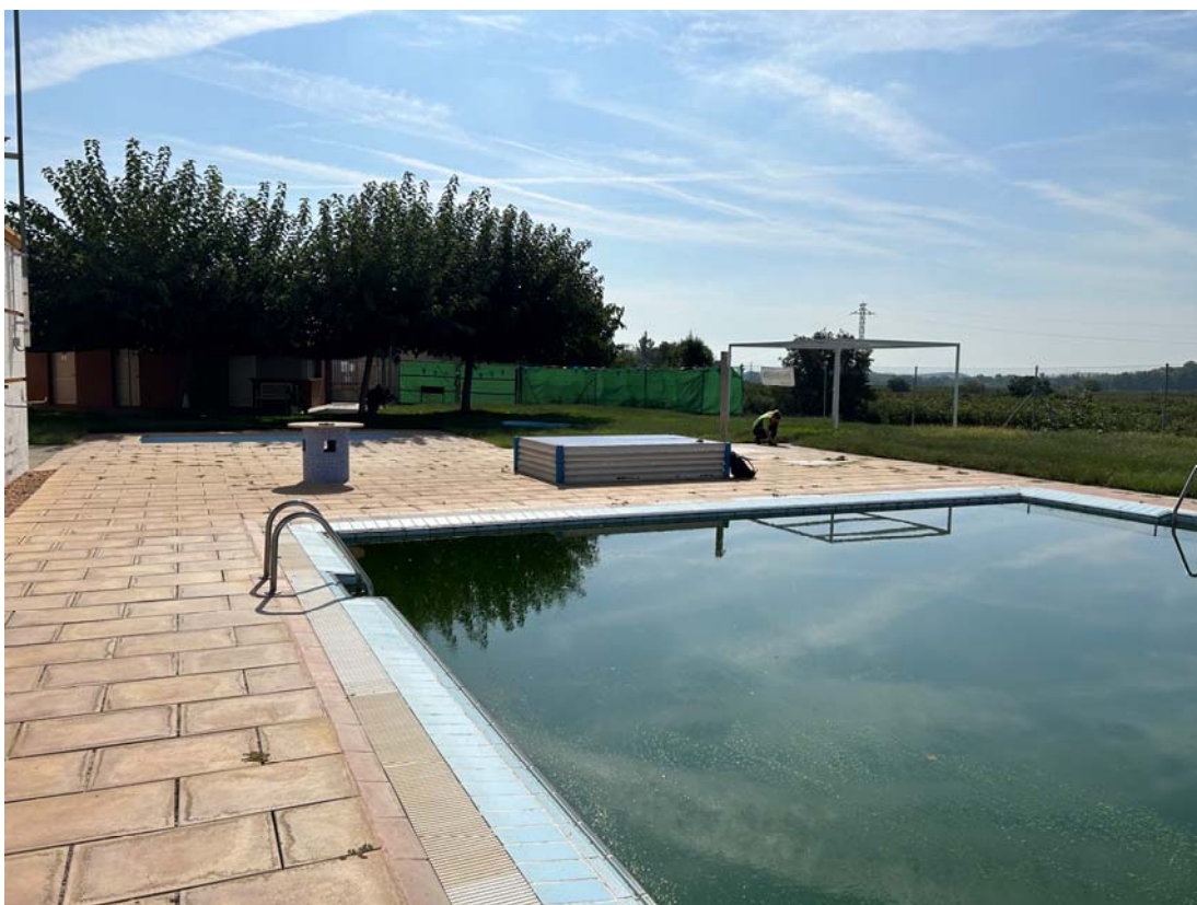
Vista general piscina i sala depuració
