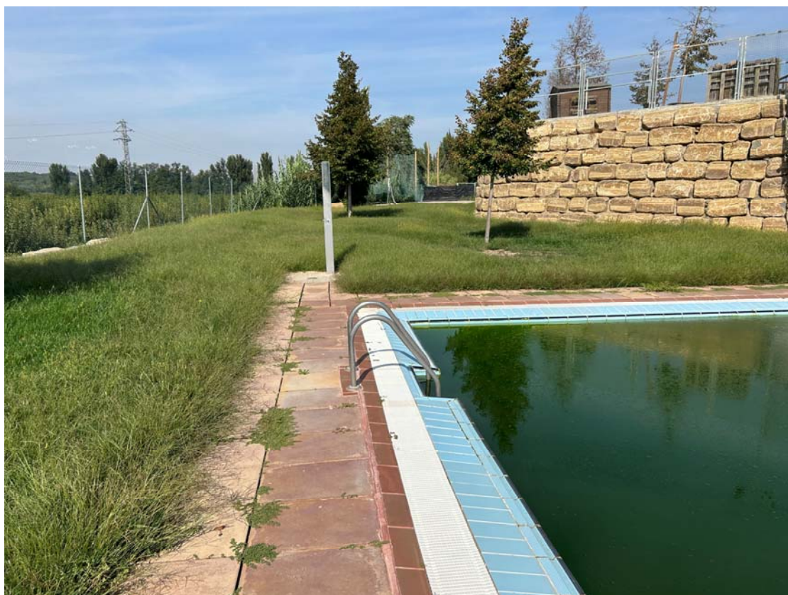
Vista general piscina
