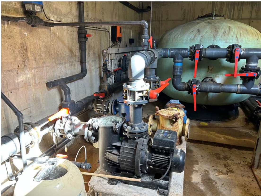
Estat actual caseta depuració soterrada
