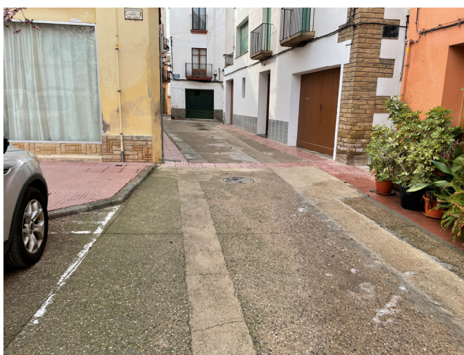
Fig 2.- Paviment carrer de la Plaça
