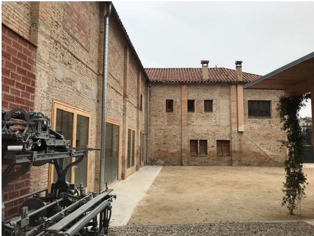
Àmbit d'intervenció (pati exterior i teulada nau C i Habitatge).
