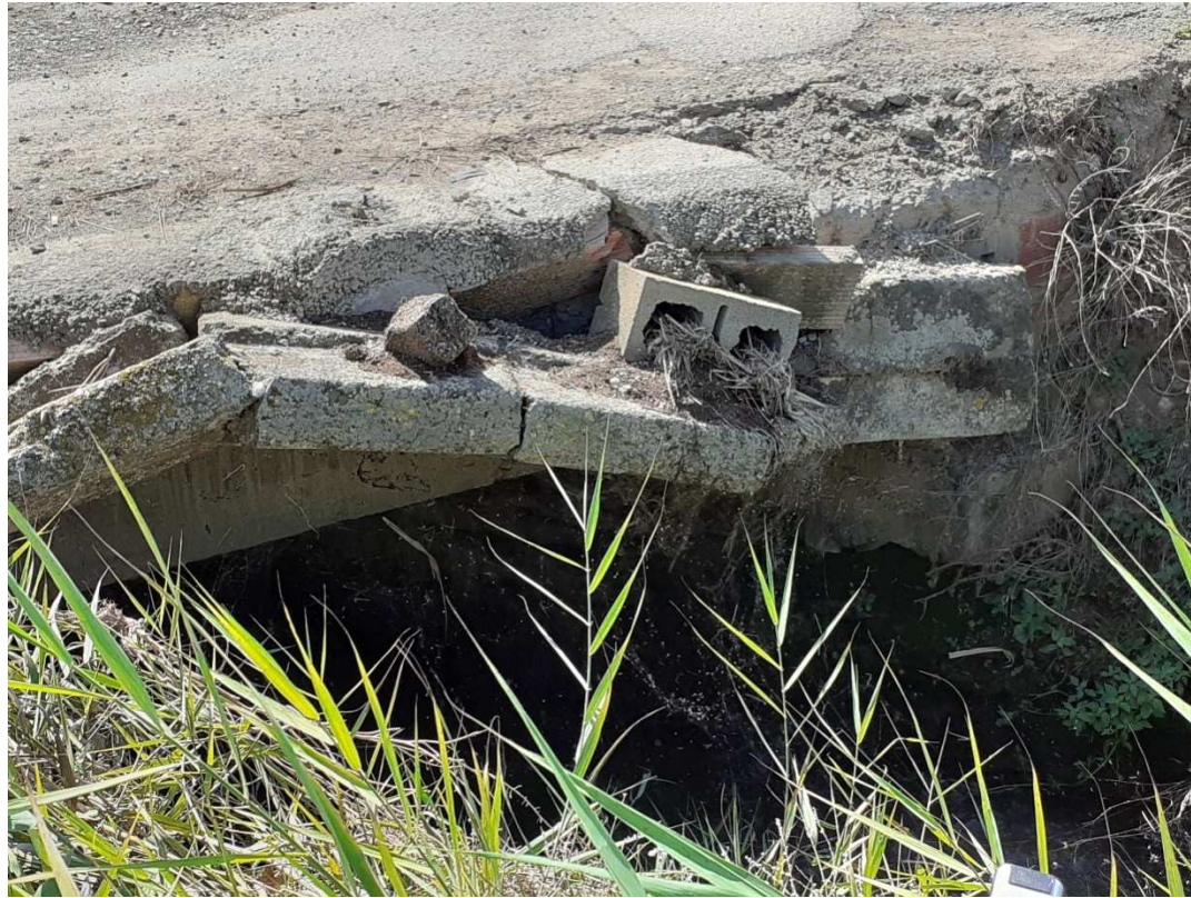
Imatge 1. Estat actual PONT 2
