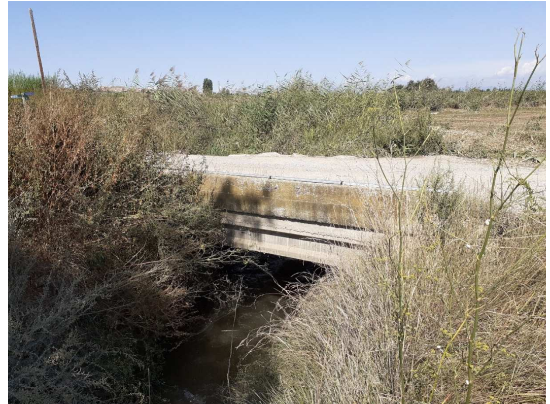
Imatge 3. Estat actual PONT 2
