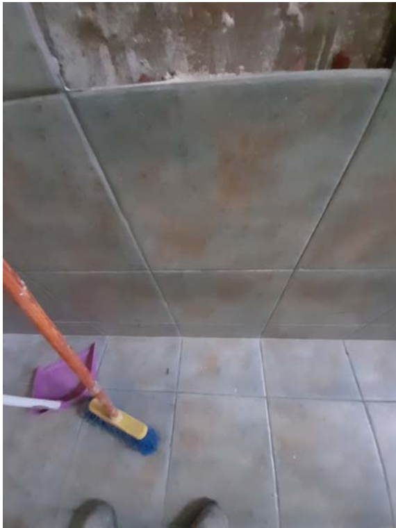
1. Estat inicial: paviment de rajola ceràmica igual que la de l'arrambador
