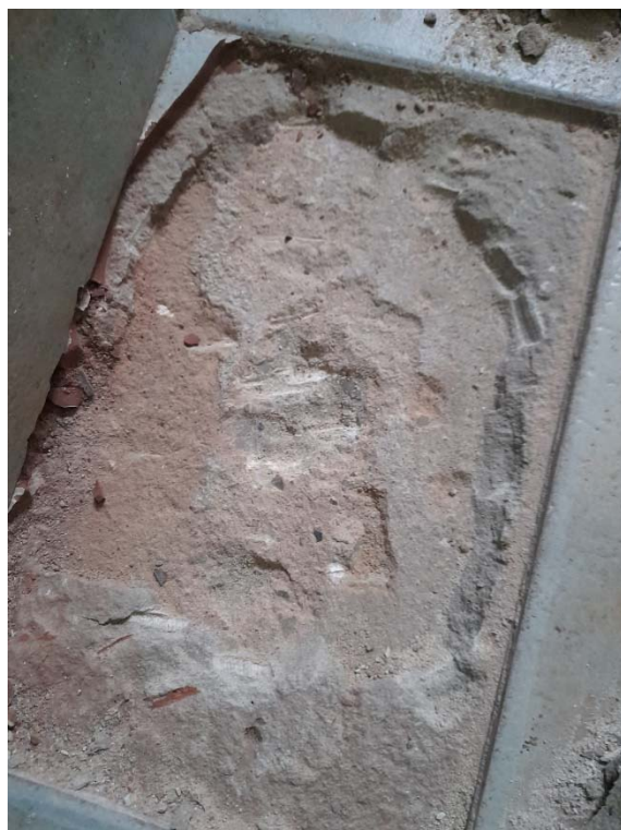
3. Es continua repicant i trobem solera de formigó.
