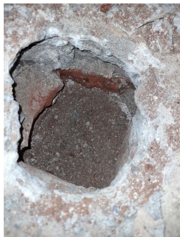
4. Sota la solera de formigó trobem un solat de rajola extrusionada de fan cuit de 4cm de gruix i sota terra.
