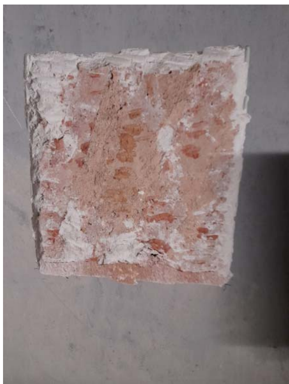
3. Es continua retirant l'enguixat i sota trobem el mur d'obra ceràmica. Per tant, no trobem indicis de revestiments originals.
