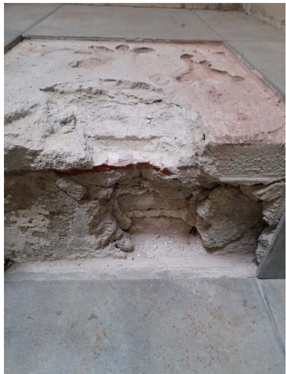
2. Formació d'escala amb esglaonat ceràmic, amb petjada amb taulell ceràmic de 4cm de gruix.. No s'observen materials originals.
