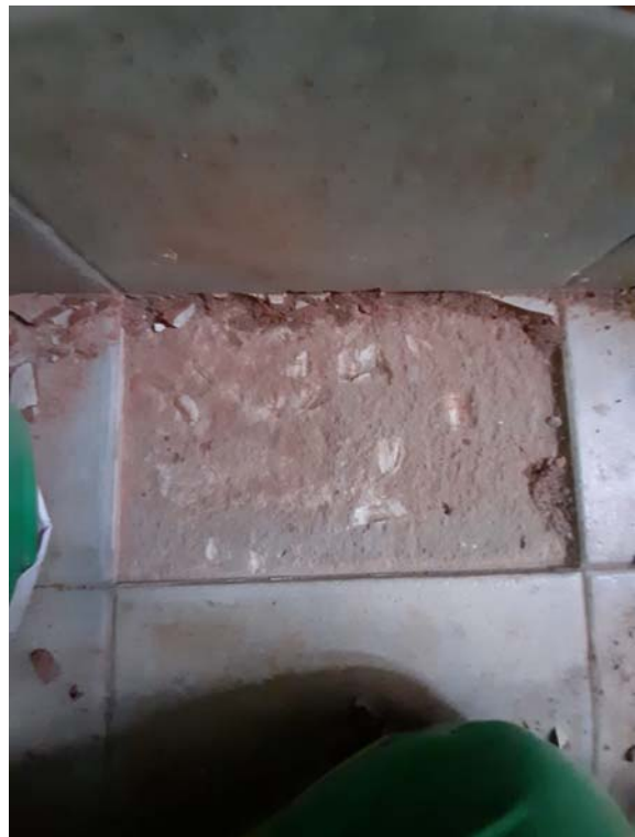
2. Retirada de rajola. Trobem el morter de ciment.
