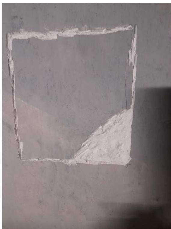
2. Es va retirant l'acabat i es comprova que immediatament sota trobem enguixat.
