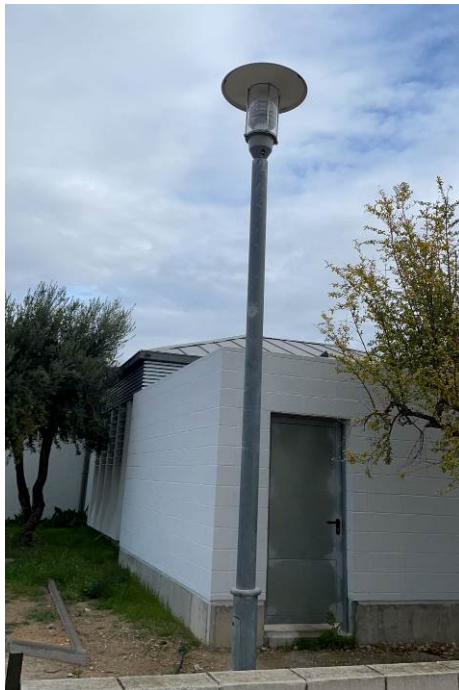
(Columna Nikolson amb làmpada de descàrrega amb difusor lumínic de 150W)
