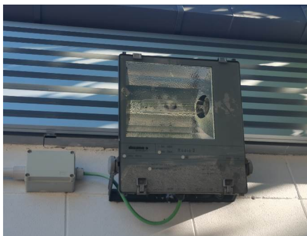
(Projector Disano simètric 400W halogenurs metàl·lics Rodio 3)
