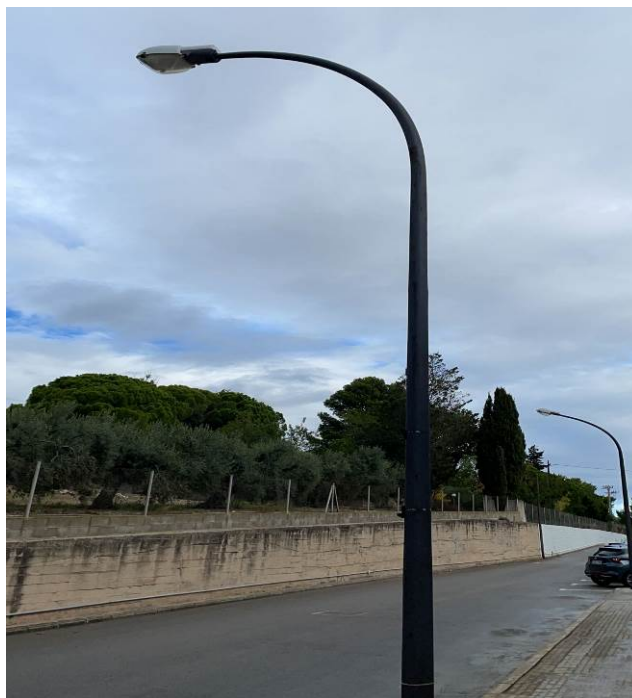
(Fanal d'enllumenat públic amb lluminària d'halogenurs metàl·lics)
