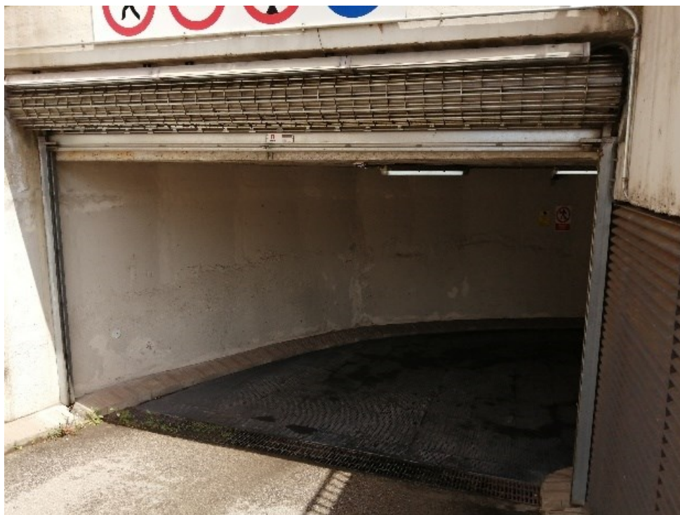
Imatge 4: Vista de la persiana actual de tancament de l'accés sud, s'integrarà a l'estació d'entrada.
