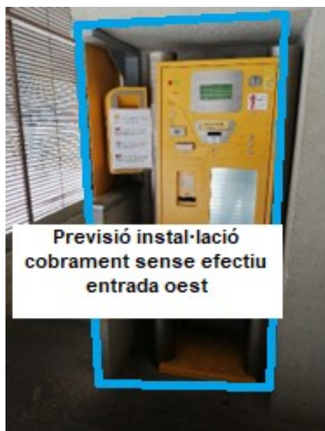
Imatge 11: Vista de l'equipament de cobrament actual a desmantellar i zona prevista d'ubicació del nou conjunt integral de cobrament sense efectiu de l'entrada oest. (més propera carretera Barcelona)
