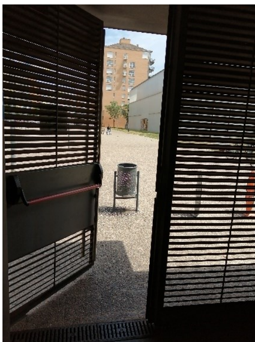
Imatge 16: Vista interior entrada per vianants oest, (propera Carretera Barcelona). Detall sortida lliure amb barra antipànic.
