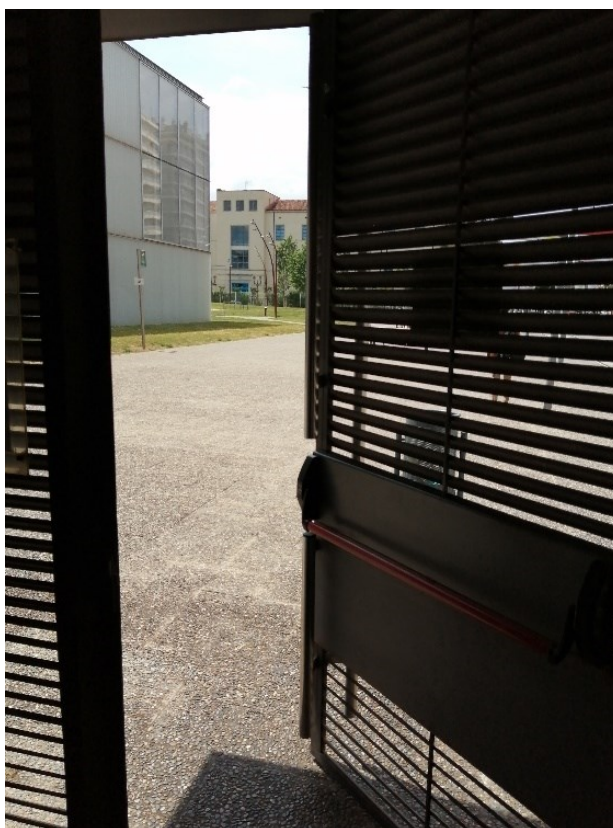
Imatge 14: Vista interior entrada per vianants est, (propera Carrer Migdia). Detall sortida lliure amb barra antipànic.
