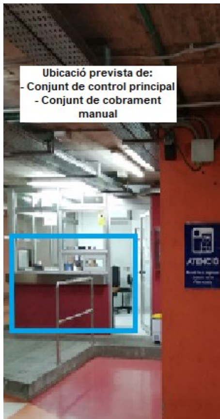
Imatge 12: Vista del Centre de Control, es preveu instal·lar el conjunt de control principal pel gestor del sistema i la caixa de cobrament manual.
