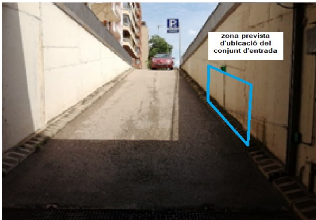
Imatge 6. Rampa accés nord, la ubicació del nou conjunt d'entrada ha de ser previa a la persiana enrotllable.
