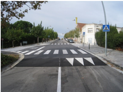
Plataforma reductora de velocitat en cruïlla
