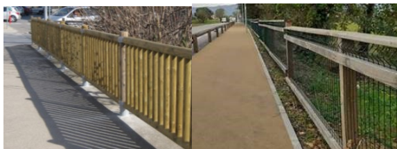
Barana de fusta
