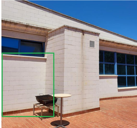
Figura 5. Ubicació de la sala tècnica que guardarà inversors, proteccions i bateries
