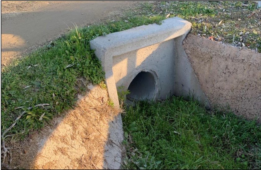
Figura 5. Obra de drenatge a ampliar.
