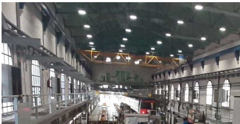
Pont grua existent, adequació a 12-15Tn
