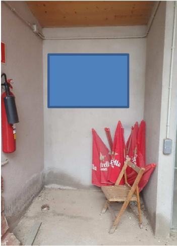
Imatge 4 espai on s'ubicarà l'inversor
