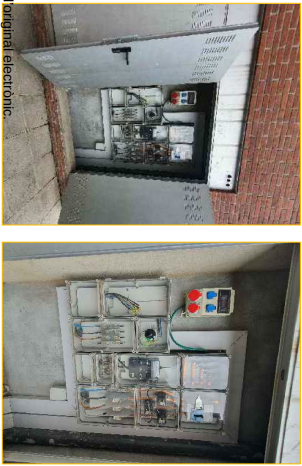
CONNEIXIÓ LÍNIA CA FOTOVOLTAICA A XARXA DISTRIBUCIÓ
