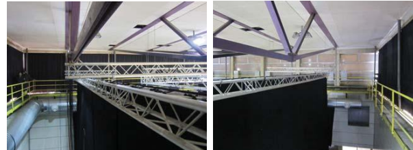
L'ESTRUCTURA DE LA COBERTA DEIXA 2 METRES LLIURES PER SOBRE DE LA CORTINA DE FONS DE L'ESCENARI.
