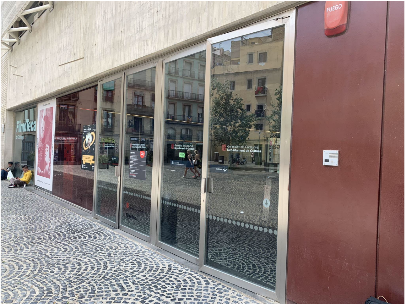
Estat actual de l'accés des de la Plaça Salvador Seguí
