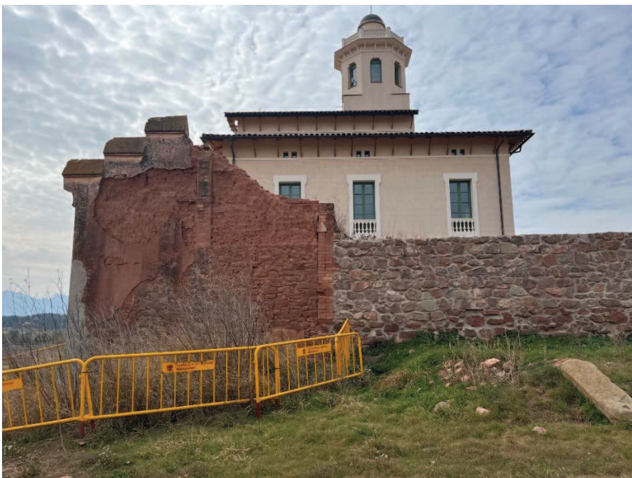
Construcció annexa, unida a la Torre Lluvià amb la tanca. Font: Santamaria Arquitectes
