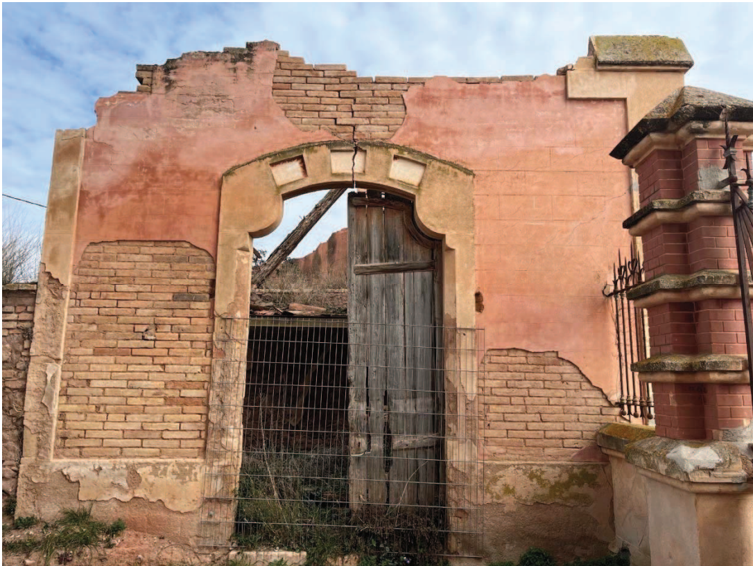
Detall porta d'entrada espai annex planta baixa
