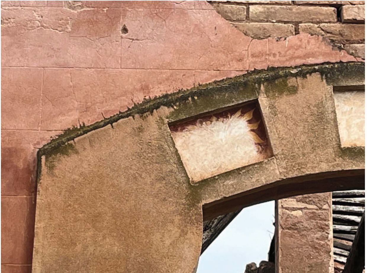
Detall esgraiat en dintell porta d'entrada principal
