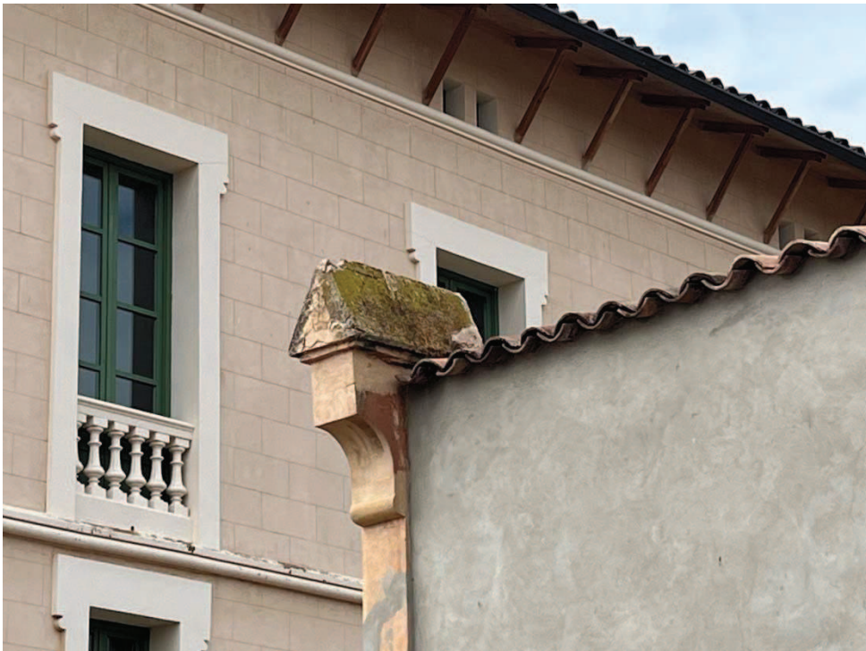
Detall coronament en parets principal i secundària edifici annex
