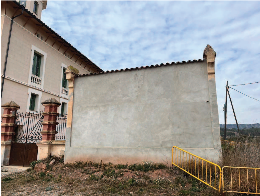
Estat actual façana sud amb revestiment de morter de ciment porland per evitar deteriorament
