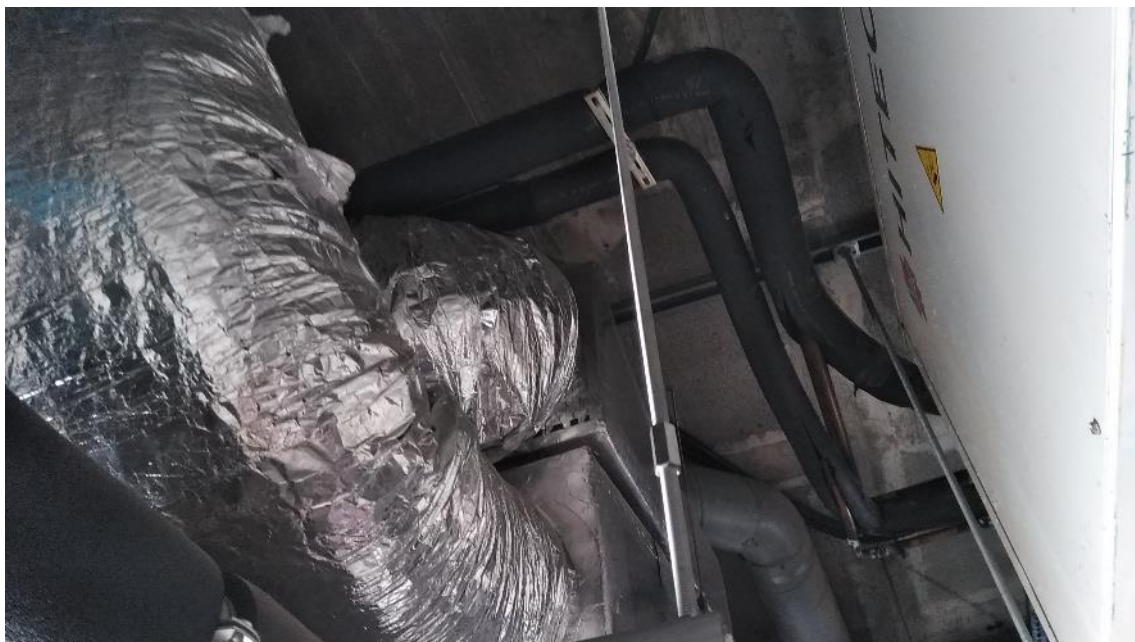
Fotografia 09. Detall 2 estat actual de les conduccions de la instal·lació de climatització que es retiraran.
