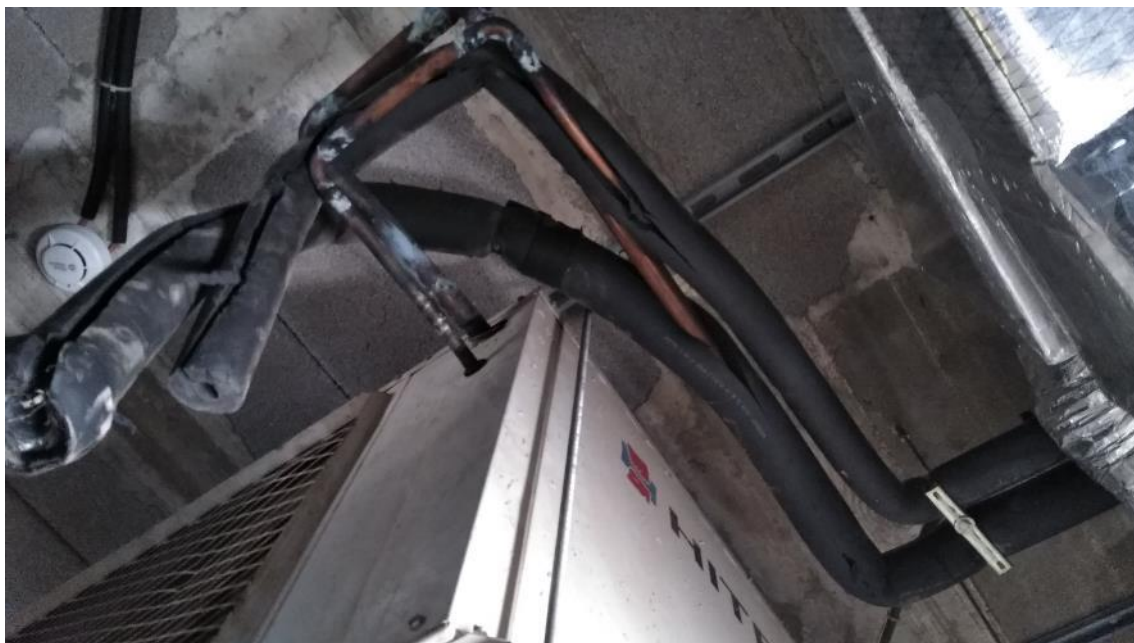
Fotografia 08. Detall 1 estat actual de les conduccions de la instal·lació de climatització que es retiraran.
