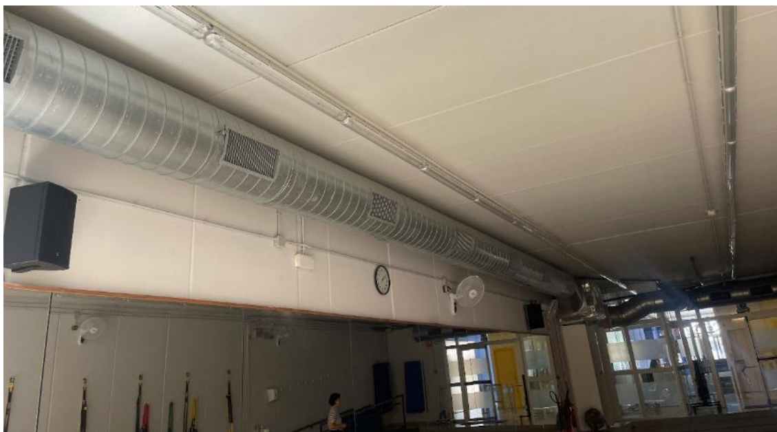
Fotografia 01. Vista general de la sala 1 del pavelló poliesportiu. En la part superior conducte d'acer galvanitzat de diàmetre 50 mm que es mantindrà per trobar-se en bon estat i donarà servei a la nova instal·lació de ventilació.
