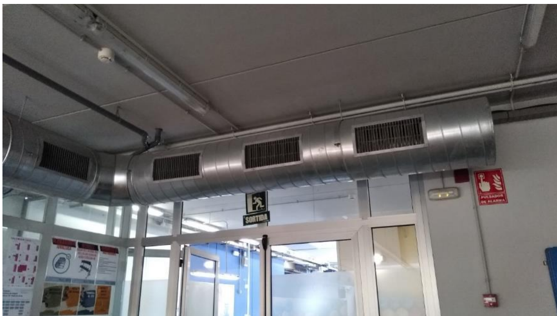
Fotografia 02. Detall 1 zona conductes existents sala 1 de la instal·lació de climatització, que tot i trobar-se en bon estat seran retirats.
