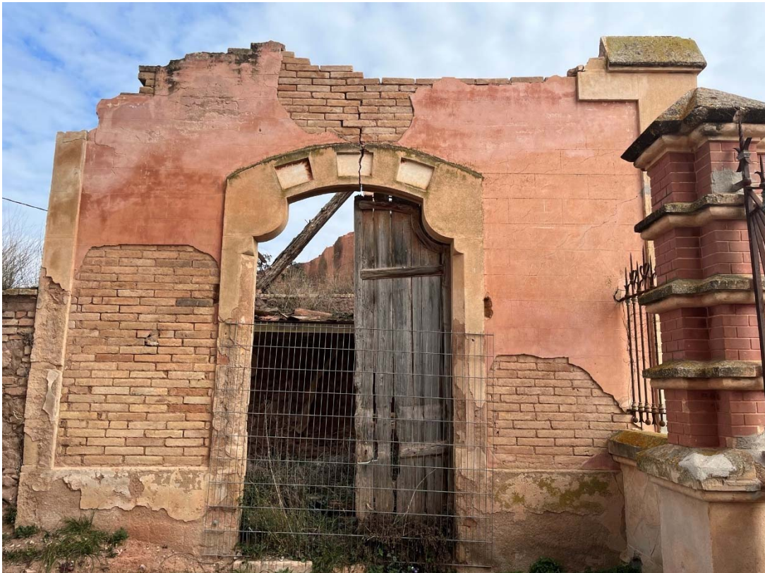
Detall porta d'entrada espai annex planta baixa
