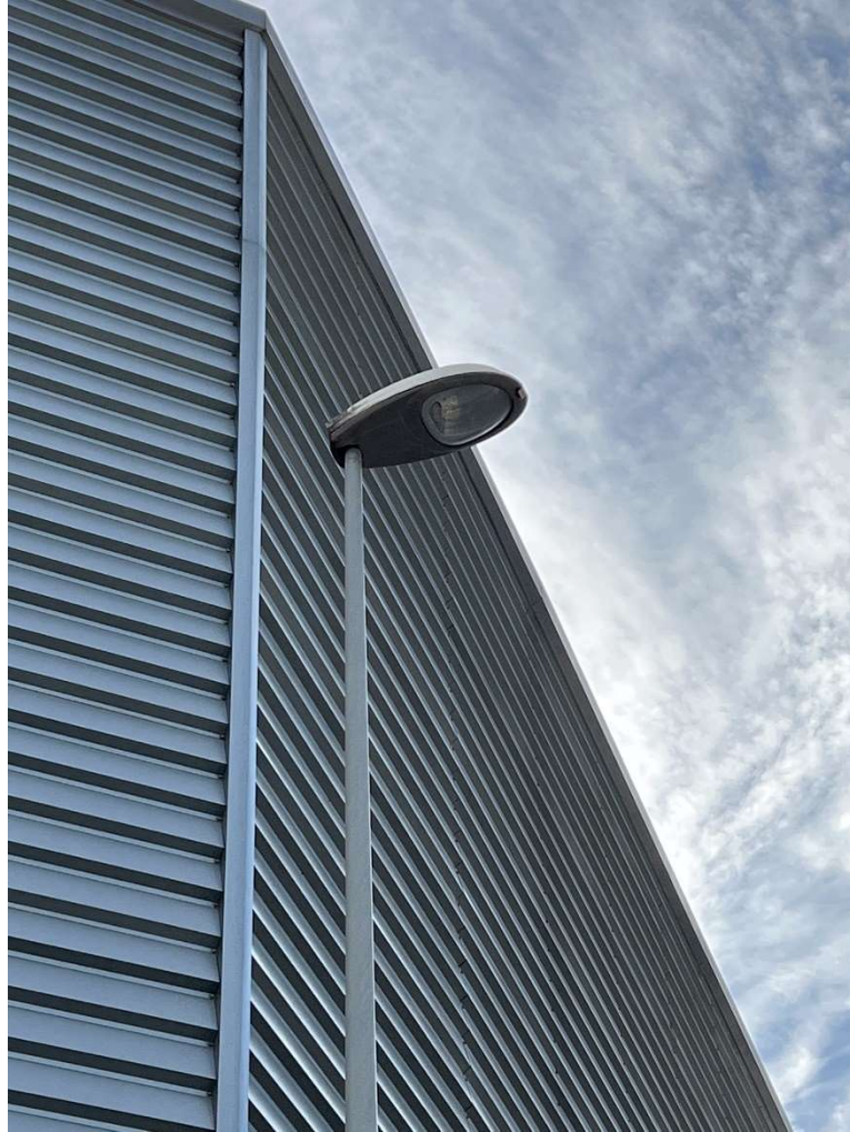
Fotografia 5: L·luminària tipus Globus existent a substituir
