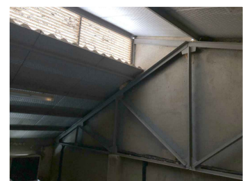
Plaques interiors de fibrociment amb amiant i aïllament adherit
