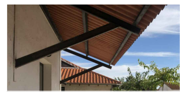
Plaques exteriors de fibrociment amb amiant
