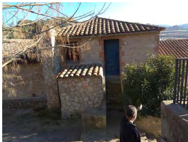
Façana nord-oest (accés)
