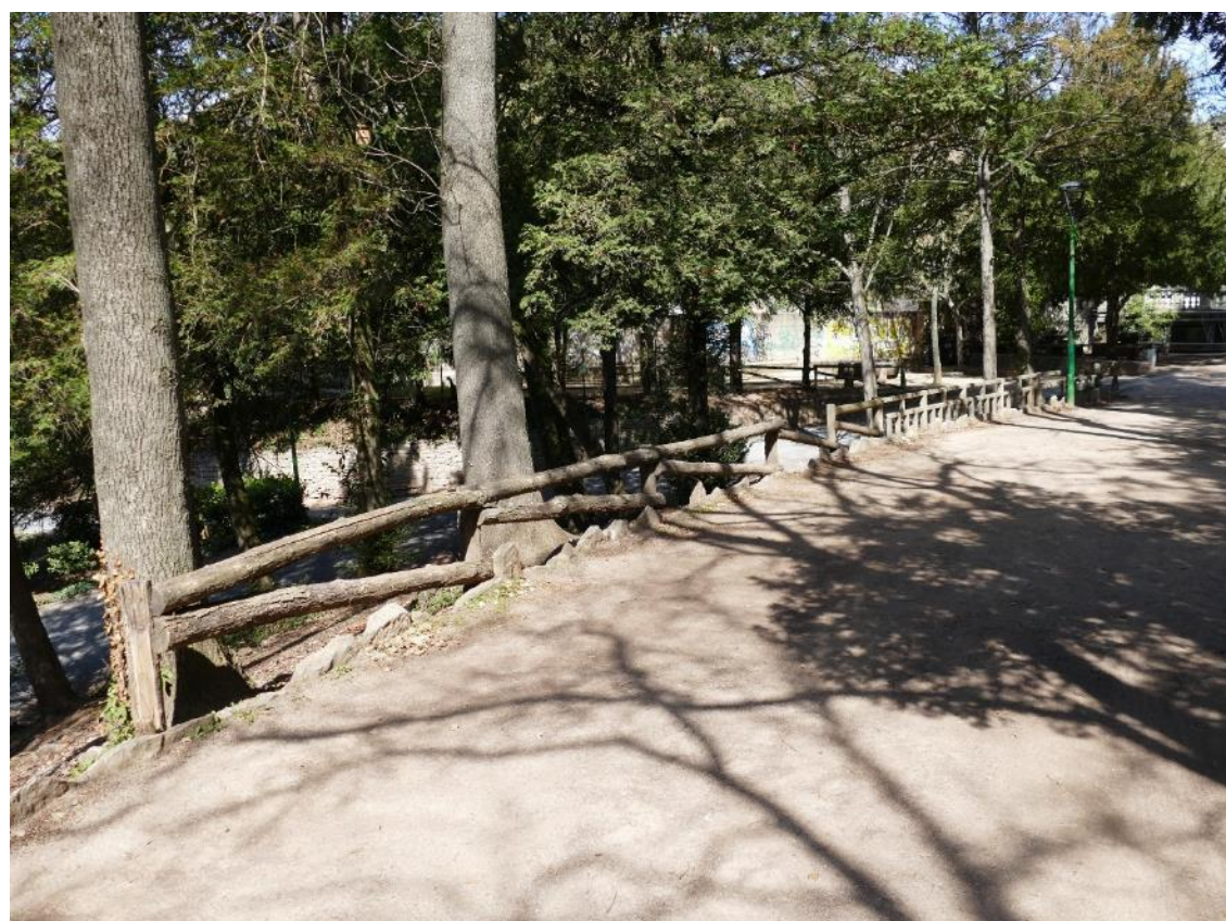
Barana final zona senyorial, amb tram inexistents i tram de diferents materials, al fons l'original de la dècada del 1950.
