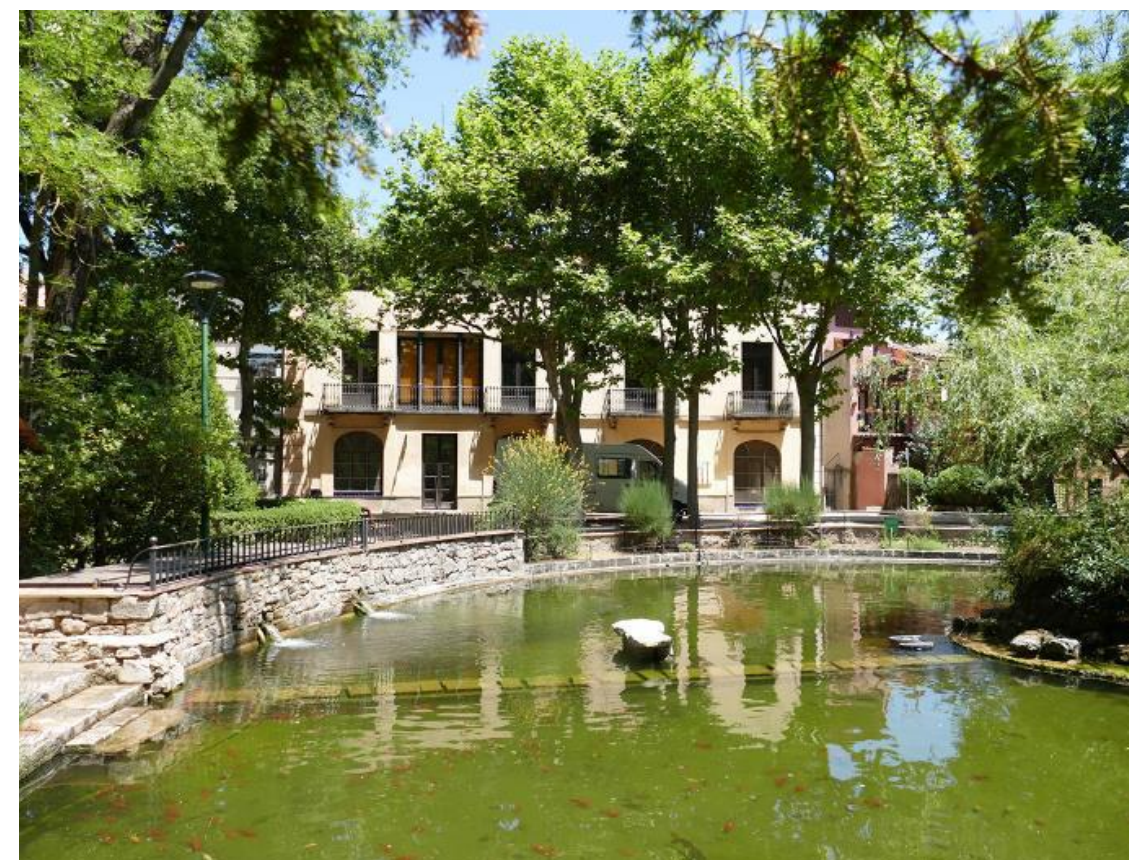
Construcció de mur i baranes per delimitar el llac
