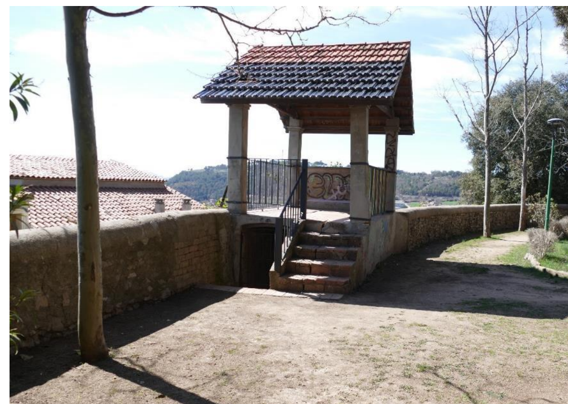
Mirador (ermita, amb l'escala per accedir-hi, i la descendent que comunica amb l'accés des del Carrer Santa Magdalena
