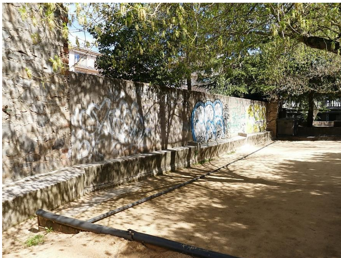
Mur Zona petanca per l'interior
