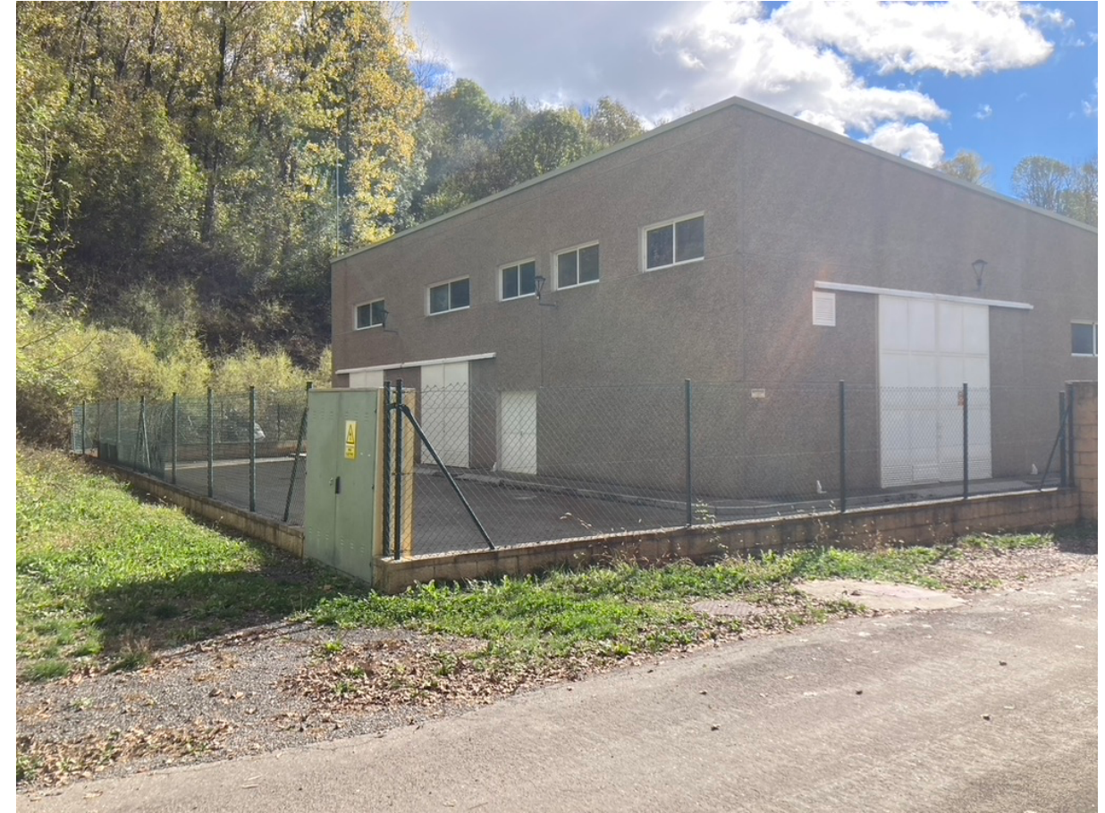
Imatge 3 Vista de l'EDAR.
