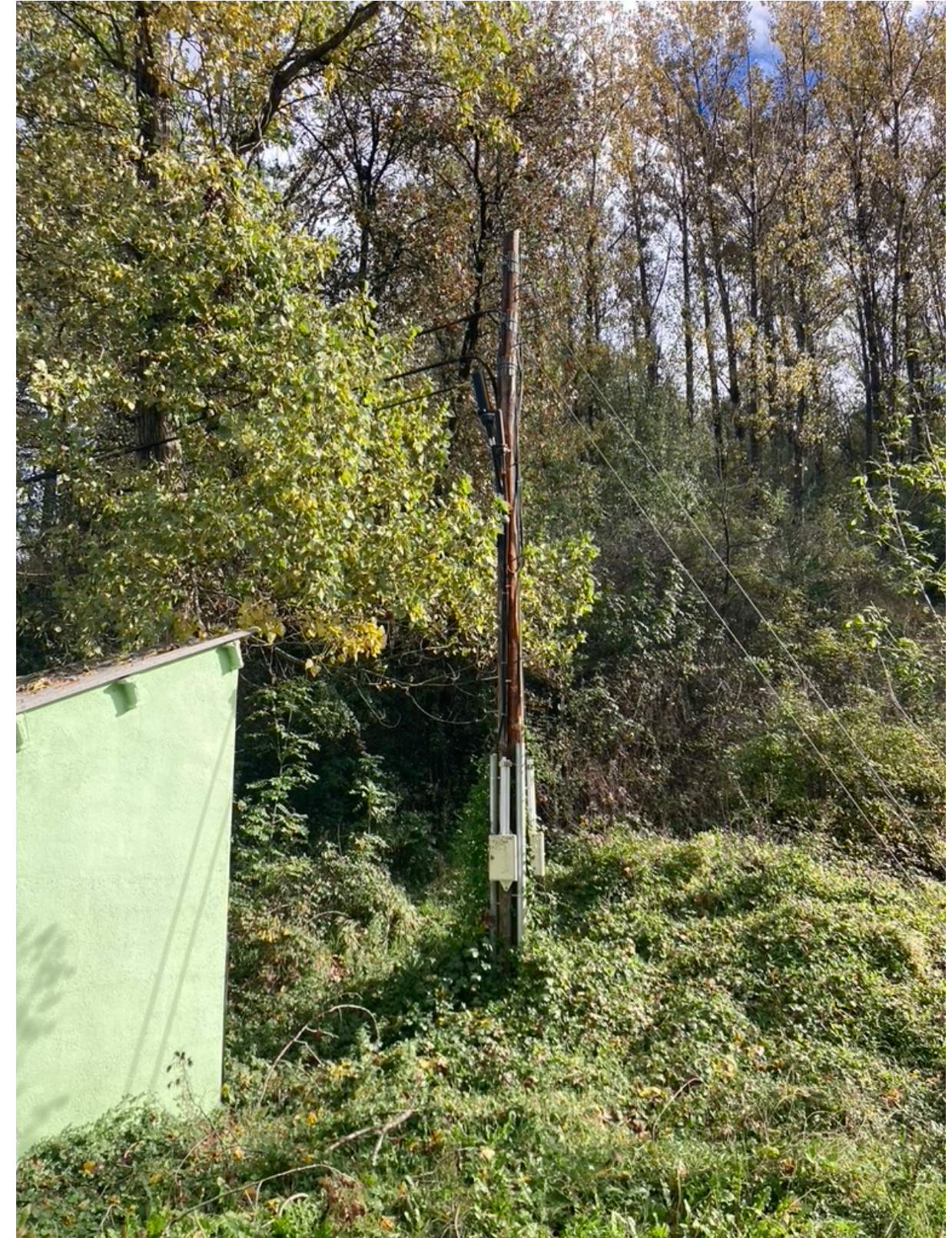
Imatge 5 Pal de telefonia que cal respectar en la construcció del centre de rentat.
