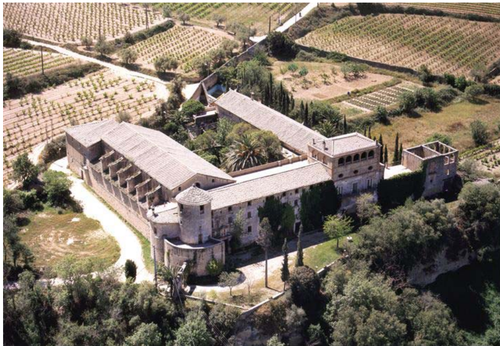
Fotografia del conjunt monumental
