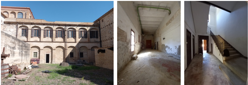
Façana migdia i porxo del Castell del Penyafort. Estat Actual
