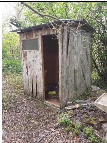
Foto 14.- Edifici en desús a demoldre
