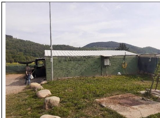
Foto 3.- Entrada edifici actual
