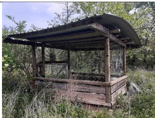
Foto 12.- Edifici en desús a demoldre
