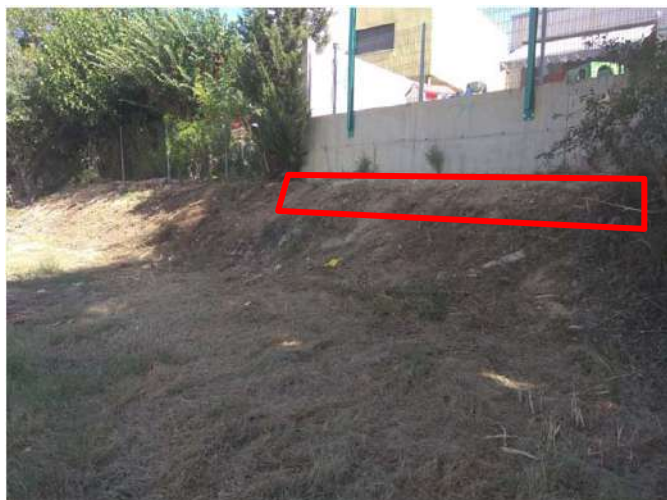
Imatge fonaments a recalçar
