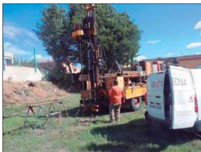
Zona Nord del solar (sondeig S-1).
