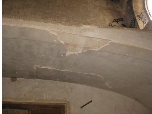
Esquerda que creua l'estructura de l'arc
