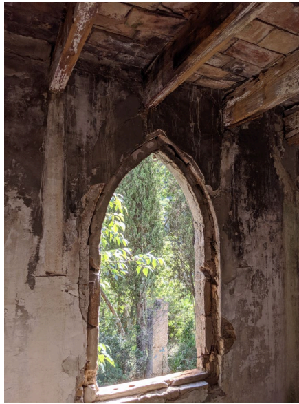
Imatge de l'estructura existent.
