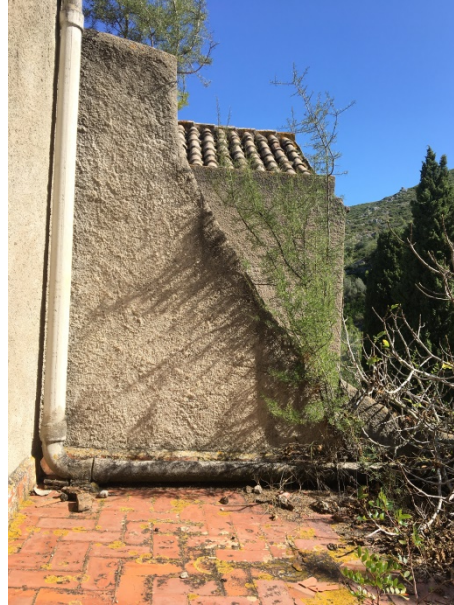
Vegetació a les cobertes inclinades
