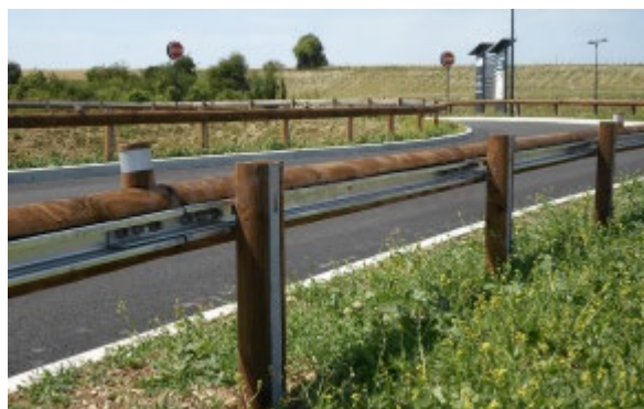
Imatge 9. Detall barrera de fusta
