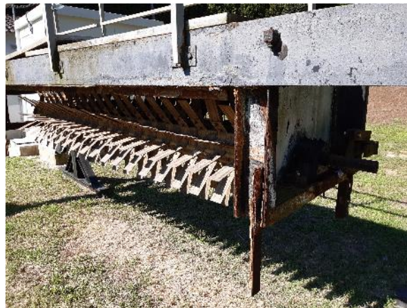
Il·lustració 2: Imatges de l'estat de les estructures dels rotors, totalment oxidats i en mal estat.
