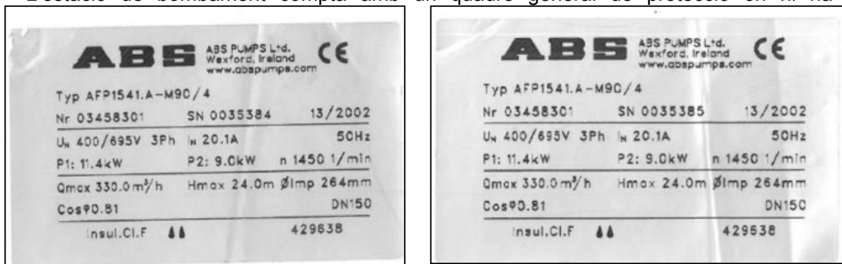
Il·lustració 2: Placa de característiques de les bombes instal·lades actualment
