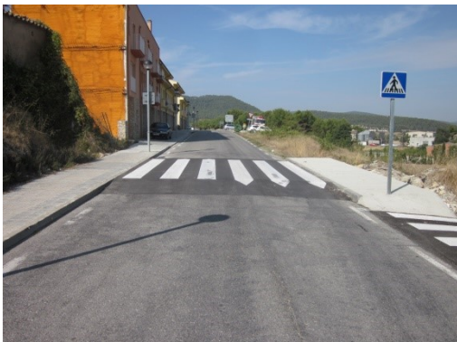
Pas de vianants elevat
