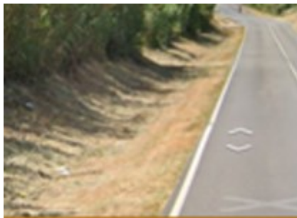
Cuneta no revestida
