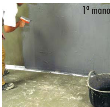
Aplicación de la 1ª mano de HIDROELASTIC .
