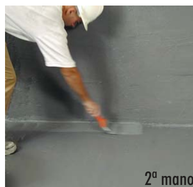
Aplicación de la 2ª mano de HIDROELASTIC .
