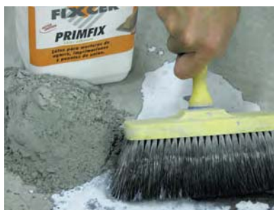
Imprimación previa con PRIMFIX + Pórtland (1:1)
