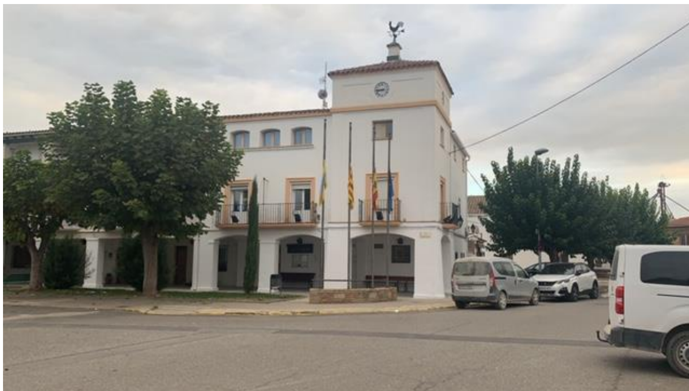
Estat actual de la façana
