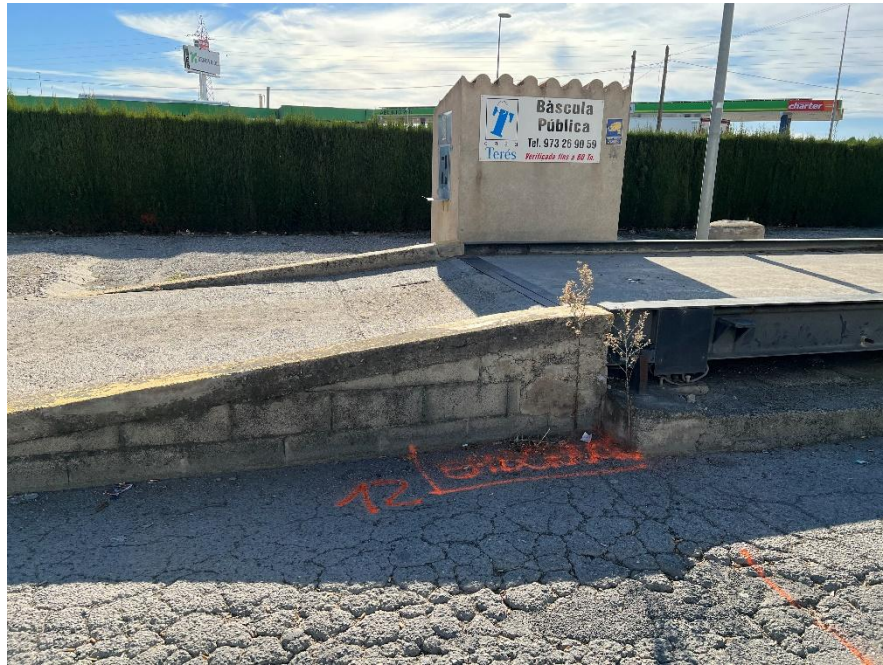
F19. C/ de Baix. Actuació 12. Instal·lació nou embornal per evacuació de les aigües
