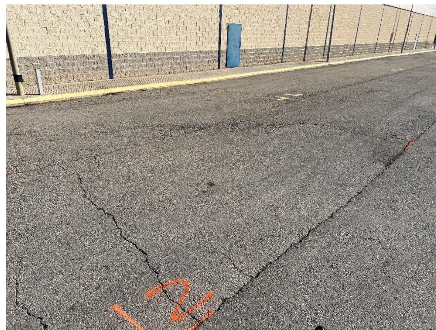
F05. C/ Tramuntana. Actuació 2. Reparació flonjall al ferm
