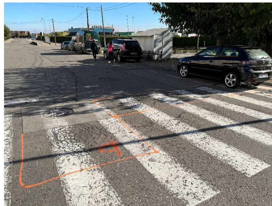
F17. C/ de Baix. Actuació 9. Reparació flonjall al ferm
