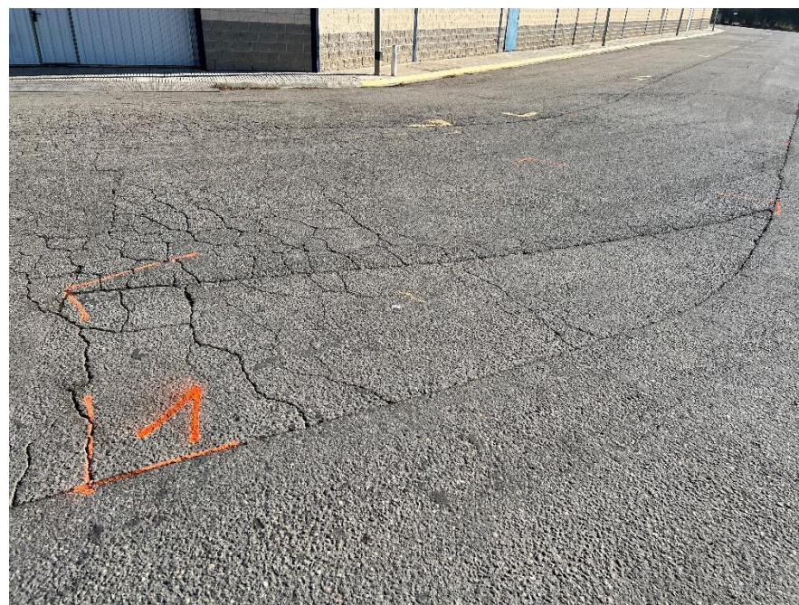
F04. C/ Tramuntana. Actuació 1. Reparació flonjall al ferm
