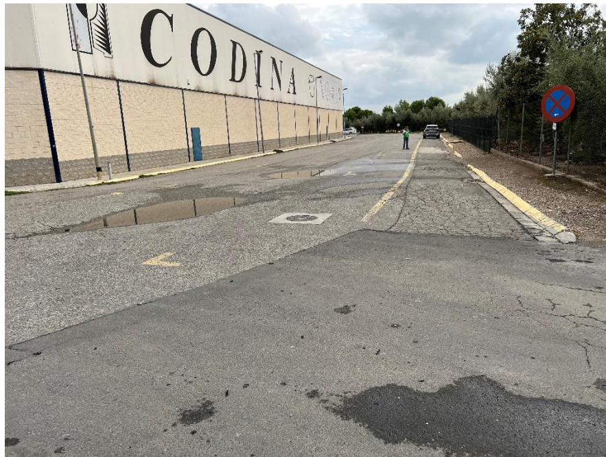
F01. C/ Tramuntana. Zones reparació flonjalls centrals i lateral
