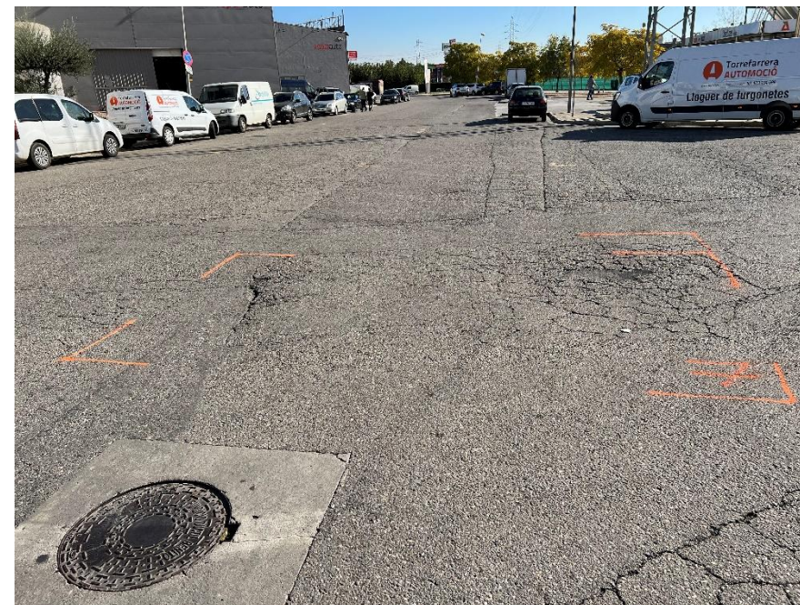
F11. C/ Indústria. Actuació 7. Reparació flonjall al ferm a la cruïlla de carrers
