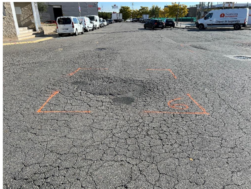
F10. C/ Indústria. Actuació 6. Reparació flonjall al ferm a la cruïlla de carrers
