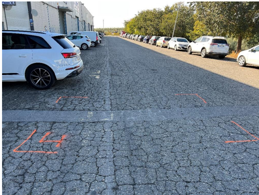
F07. C/ Tramuntana. Actuació 4. Reparació flonjall al ferm al final de carrer
