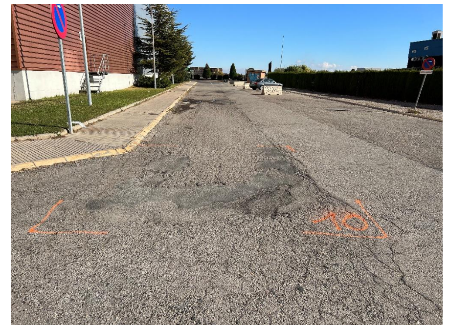
F18. C/ de Baix. Actuació 10. Reparació flonjall al ferm
